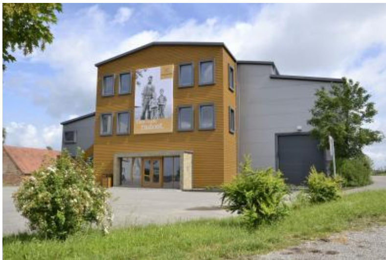
Obr. 10: Hlavní budova (Zdroj: Sonnentor.cz, 2015)
