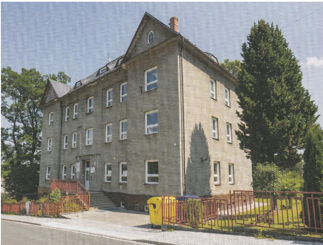
Obrázek 16 - Budova Internátu a jídelny SŠ Rýmařov (2020) (zdroj: Lašák, 2020)
