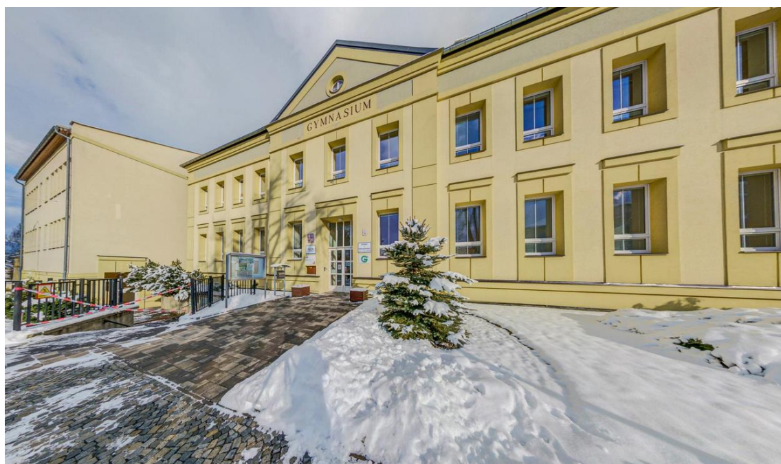
Obrázek 12 - Budova Gymnázia Rýmařov (2020) (zdroj: gymsosrym.cz)
