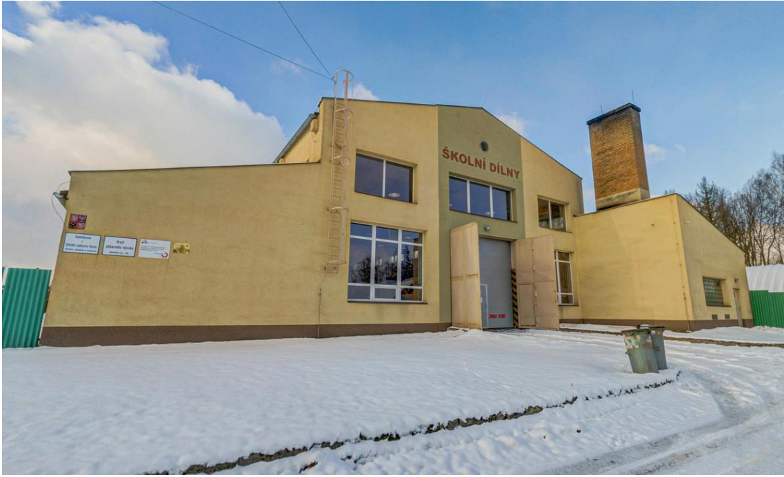
Obrázek 17 - Budova Školních dílen (zdroj: gypsosrym.cz)
