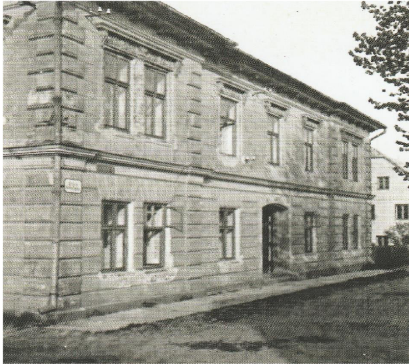
Obrázek 7- Budova ZUŠ Rýmařov (40. léta 20. století) (zdroj: Lašák, 2020)
