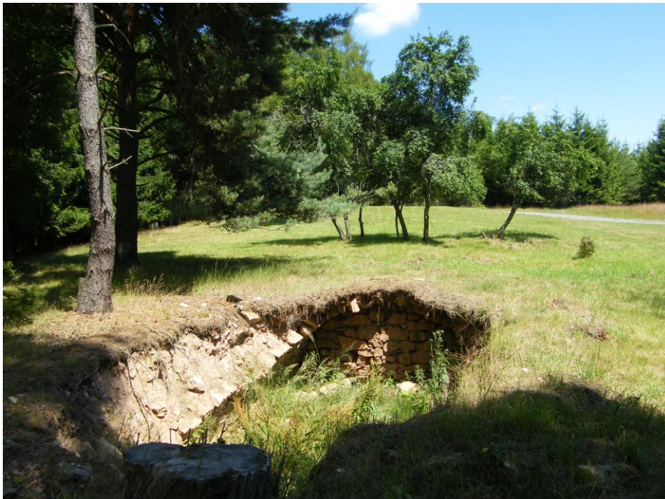
Příloha č. 4. Zřícený sklep v zaniklé osadě Umíř
