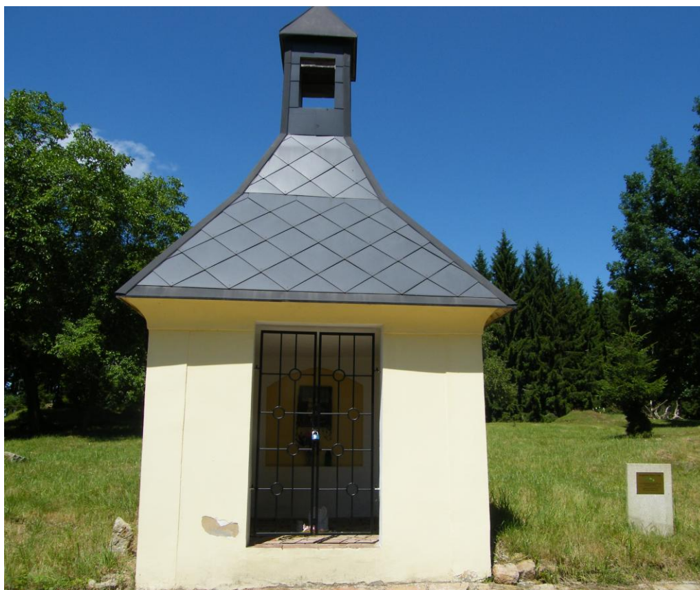
Příloha č. 2. Opravená kaplička v zaniklé osadě Umíř
