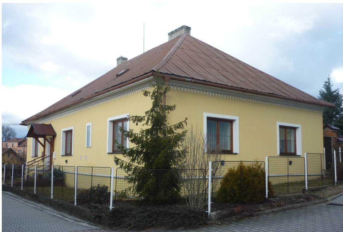
Obrázek č. 2 - Zděná škola postavena v roce 1838, dnes slouží jako fara.
