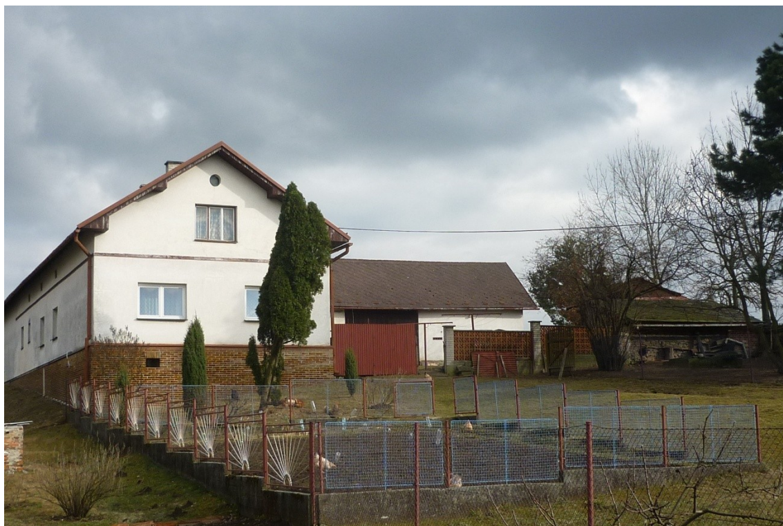
Obrázek č. 1 - Z první školní budovy se dnes dochovaly pouze základy, a to na zahradě tohoto rodinného domu č. p. 3.
