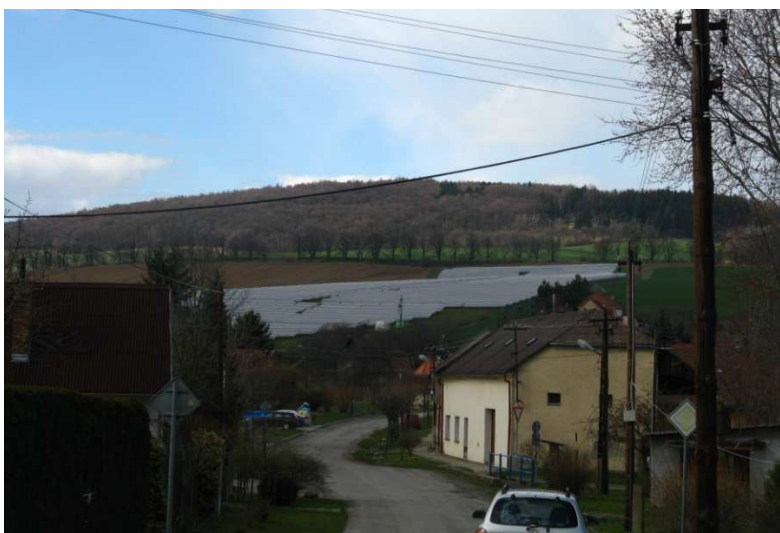
Obrázek 6 – Fotovoltaická elektrárna Honětice (foto: autorka)
