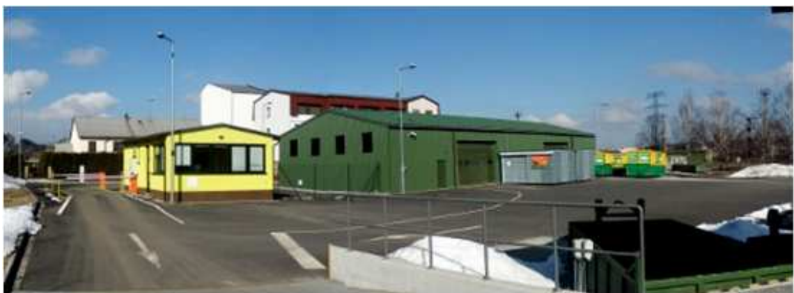
Obr. 10: Hlavní budova sběrného dvora (Zdroj: vlastní)
