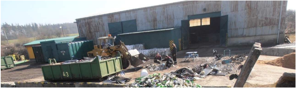
Obr. 8: Budova existující třídírny odpadů (Zdroj: vlastní)
