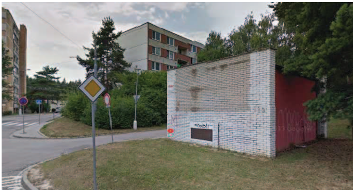
Obr.22 Objekt JME v ulici Černého s vyznačením přibližné polohy vztažné značky „B“ [12-upraveno]
