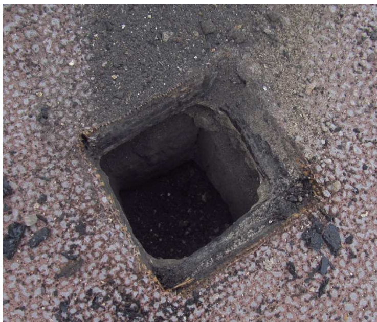
Obrázek 28: Sonda do střešní pláště-viditelná tloušťka hydroizolační vrstvy – 25 mm [vlastní]
