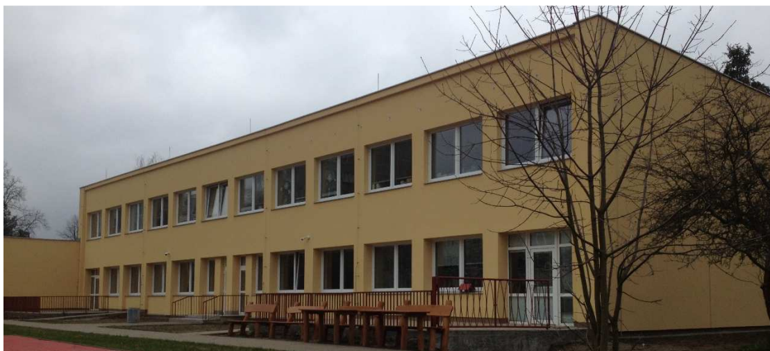
Obrázek 35: Pohled na zvolenou budovu základní školy – nový stav po zateplení a výměně oken [vlastní]
