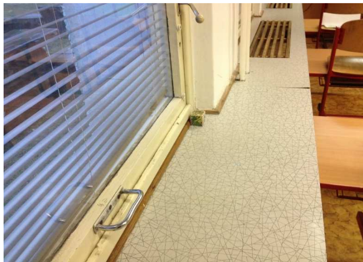
Obrázek 29: Původní starší okna s pohledem na parapet překrývající také otopná tělesa [vlastní]
