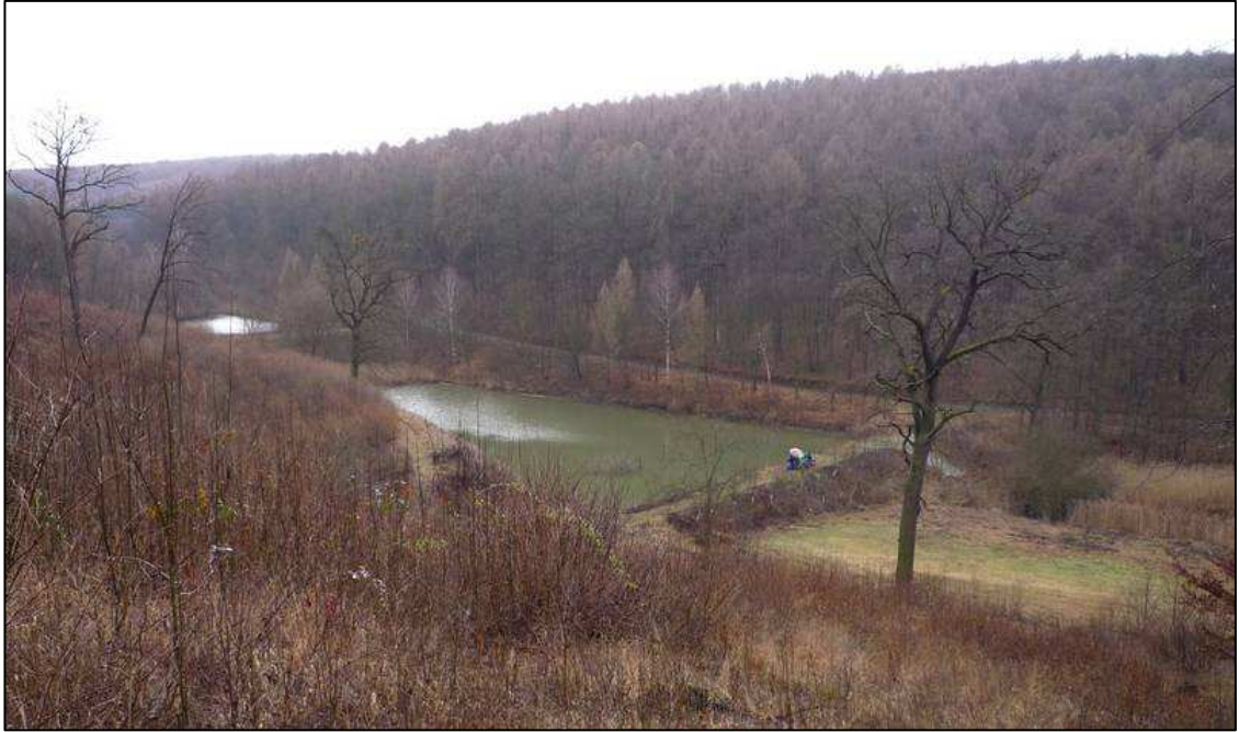
Obr. 7.5 Vzdušný líc hráze a zahrází vodní nádrže Bezedník III
