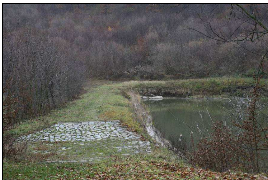
Obr. 7.7 Pohled na hráz a bezpečnostní přeliv
