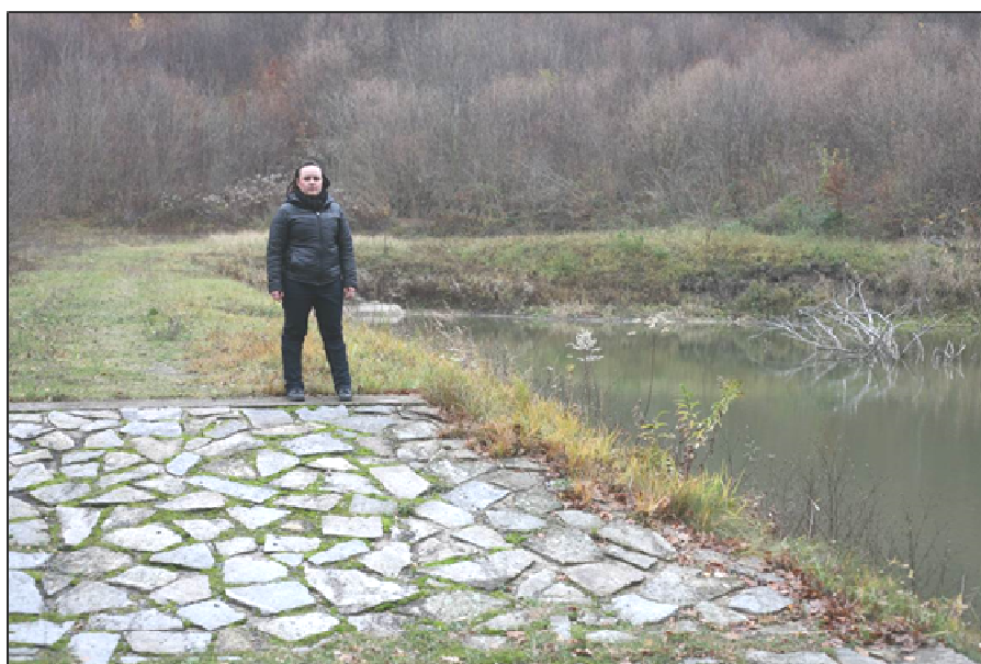
Obr. 2.1 Pohled na hráz
