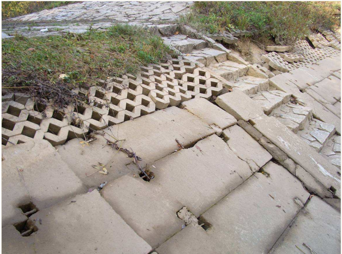
Obr. 7.6 Detailní pohled na návodní líc hráze vodní nádrže
