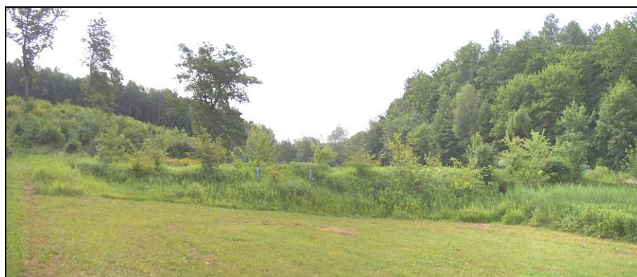
Obr. 2.2 Pohled na vzdušnou stranu hráze (Pařílková, 2006)
