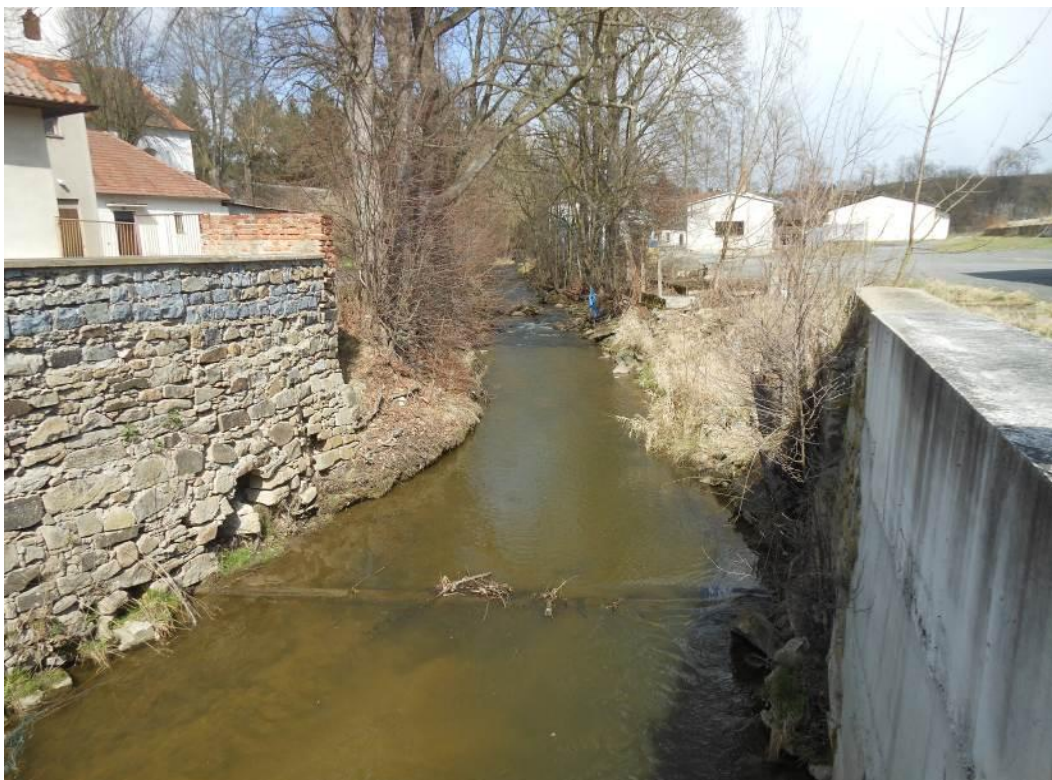
Obr. č. 1: Úsek před kovovou lávkou (ř. km 24,406)
