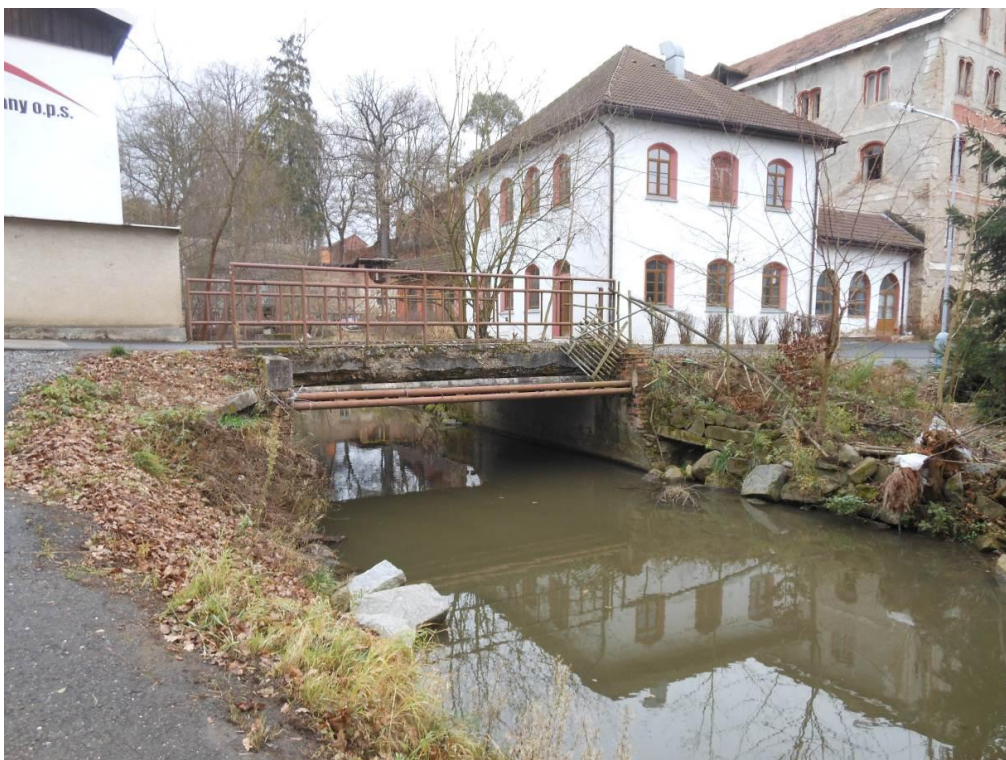
Obr. č. 14 Lávka u SOU Červený Hrádek (ř. km 21,394)
