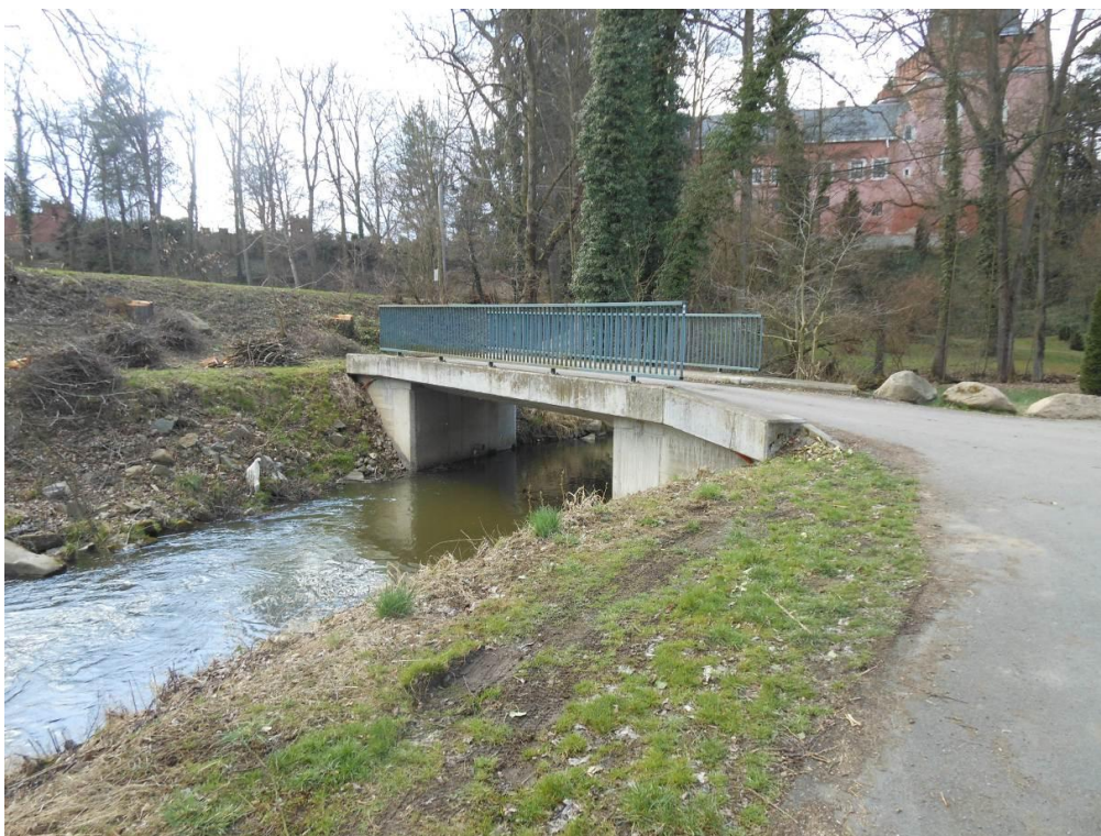
Obr. č. 10: Silniční most v lesoparku Červený Hrádek (ř. km 22,155)
