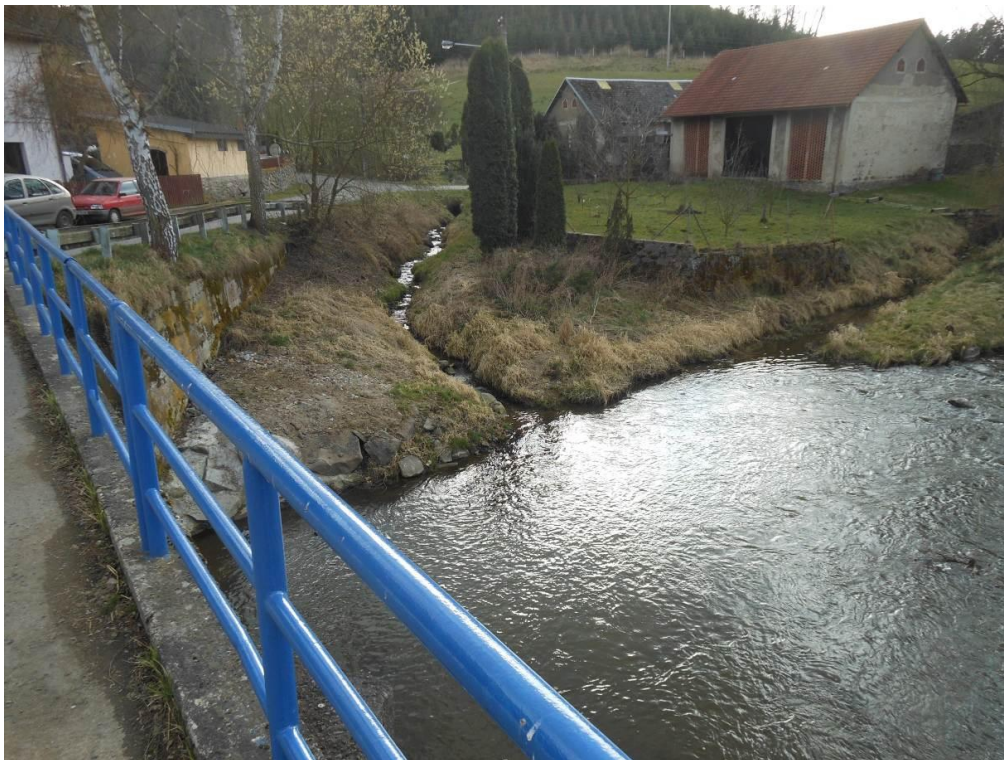
Obr. č. 21: Soutok Mastníku se Sestrouňským potokem (vlevo) a náhon vlévající se do Mastníka (ř. km 15,313)
