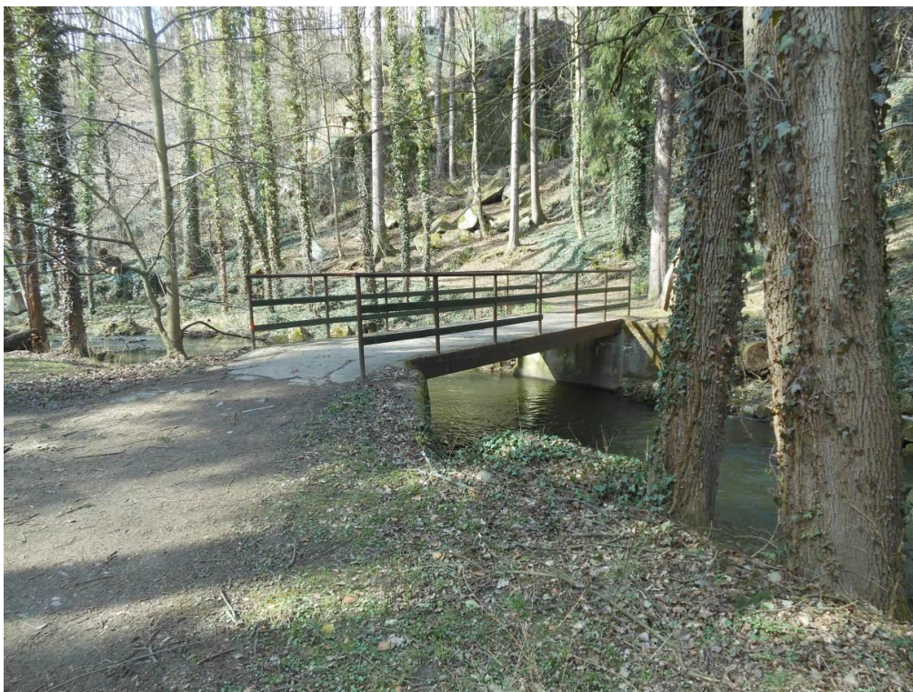
Obr. č. 11: Lávka v lesoparku Červený Hrádek (ř. km 21,970)
