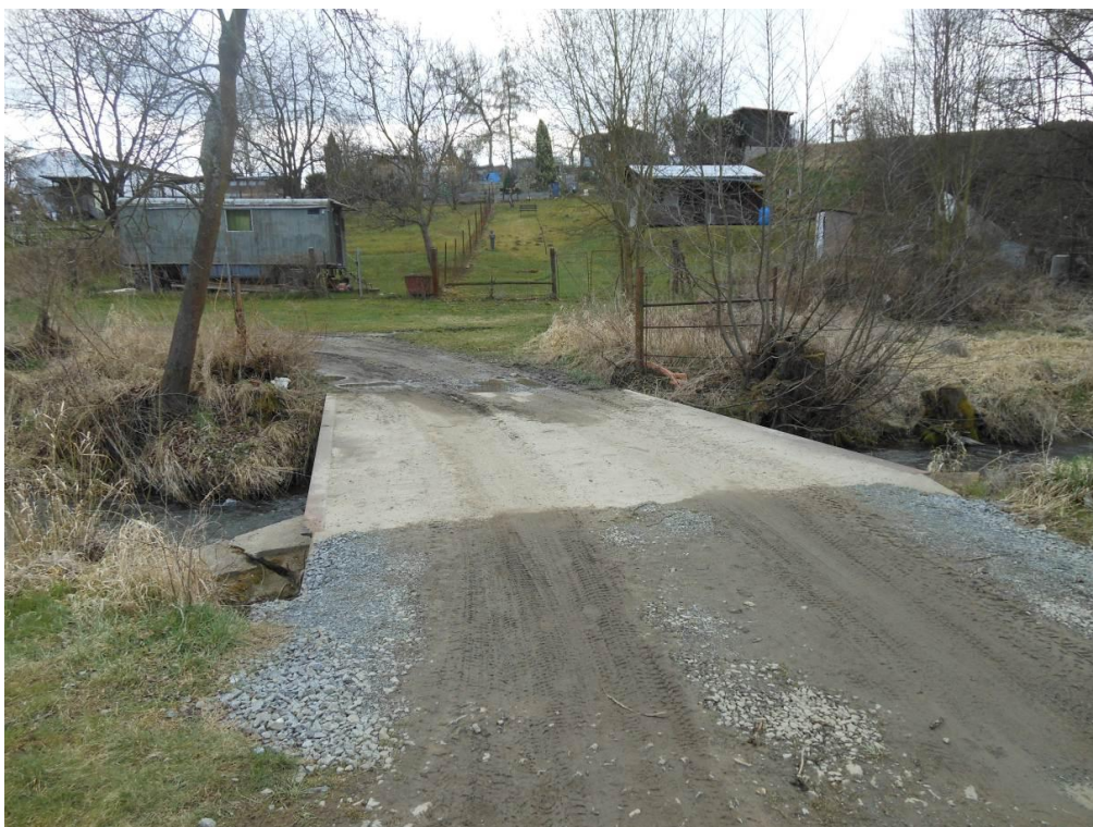
Obr. 8: Betonová panel sloužící jako lávka v Kosově Hoře ř. km (23,269)
