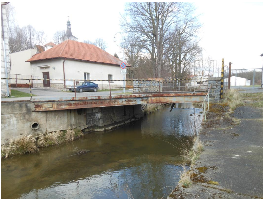
Obr. č. 2: Kovová lávka v Kosově Hoře (ř. km 24,406)
