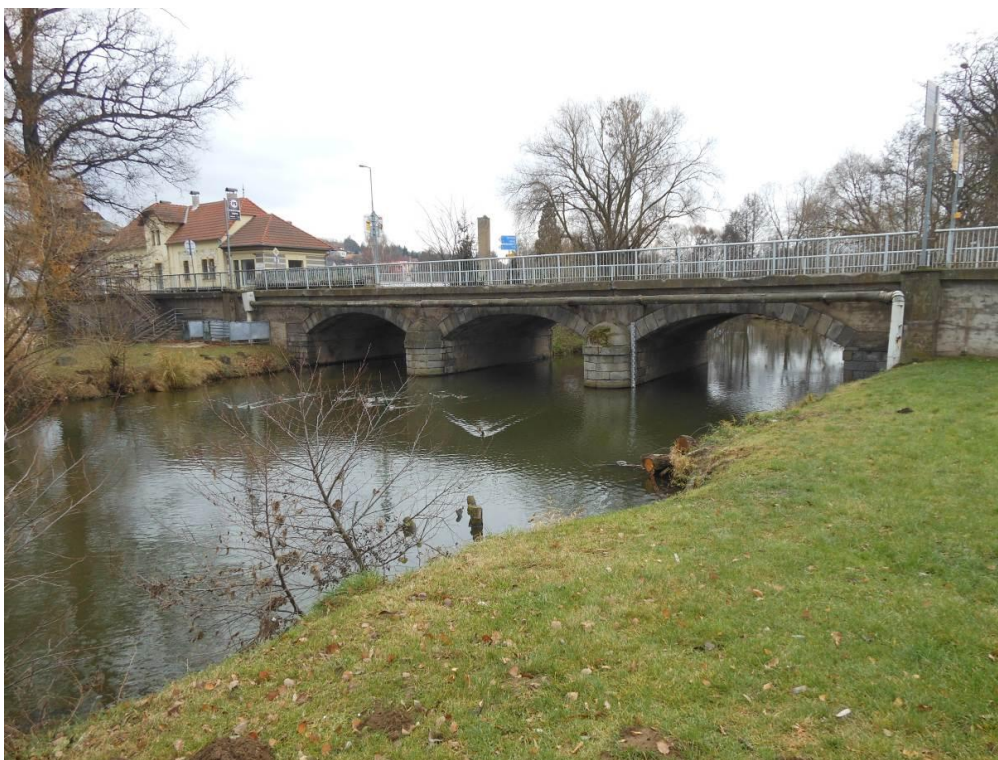
Obr. č. 18: Silniční most v Sedlčanech (ř. km 19,555)
