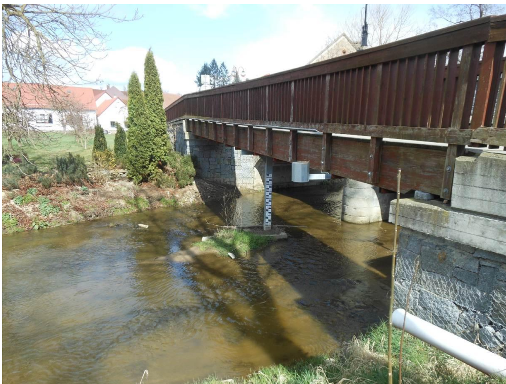
Obr. č. 4: Silniční kamenný most v Kosově Hoře (ř. km 24,192)
