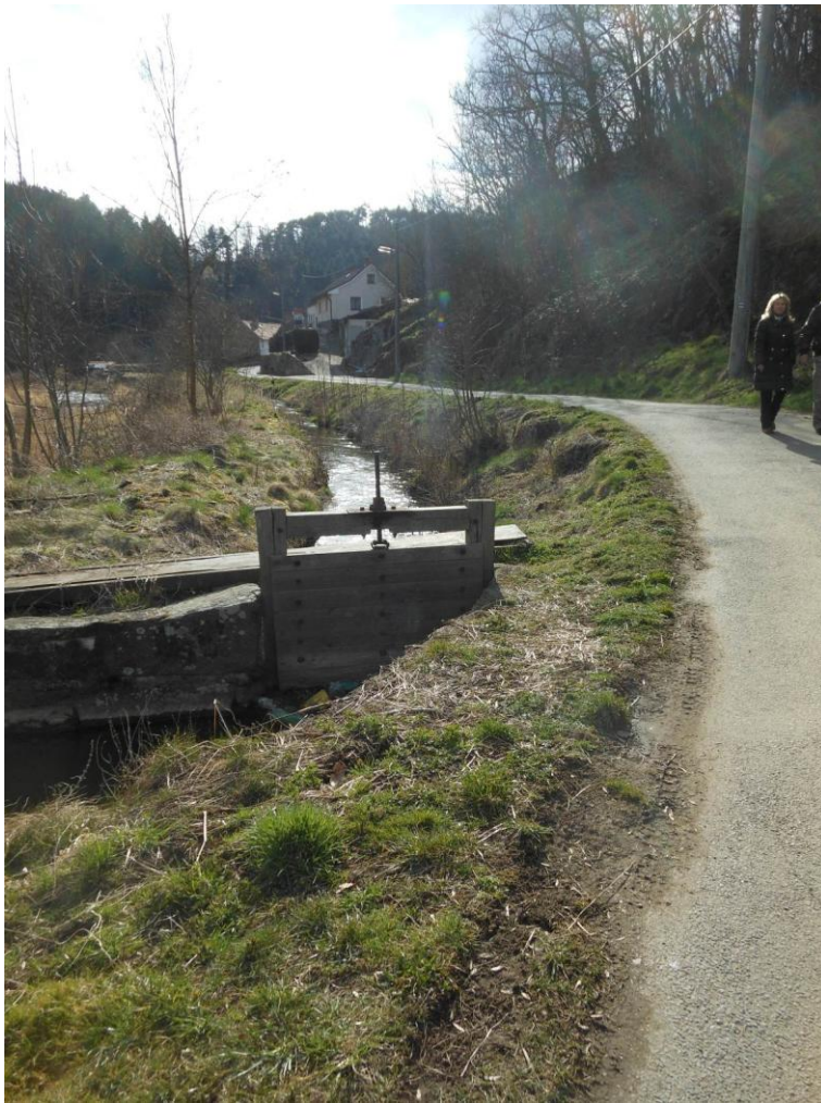
Obr. č. 22: Náhon v obci Osečany vedoucí k místní pile (ř. 13,995)
