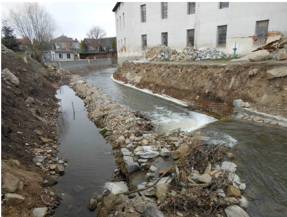
Obr. č. 7: Probíhající opravy koryta v Kosově Hoře
