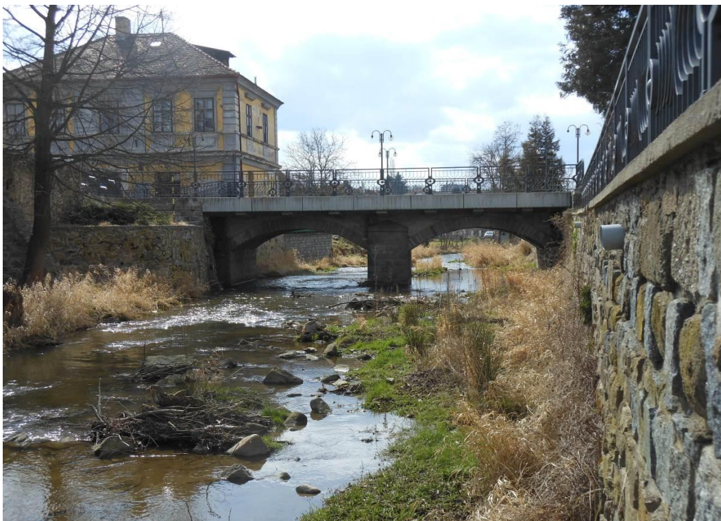
Obr. č. 3: Silniční kamenný most v Kosově Hoře (ř. km 24,531)
