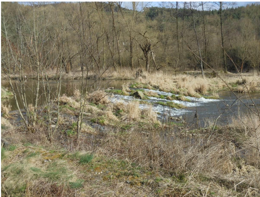
Obr. č. 22: Jez v Osečanech (ř. km 13,995)
