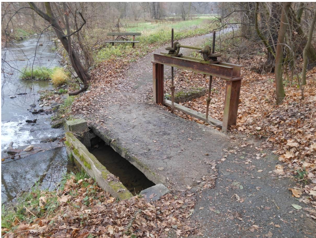
Obr. č. 16: Stavidlo k náhonu u jezu (ř. km 21,293)
