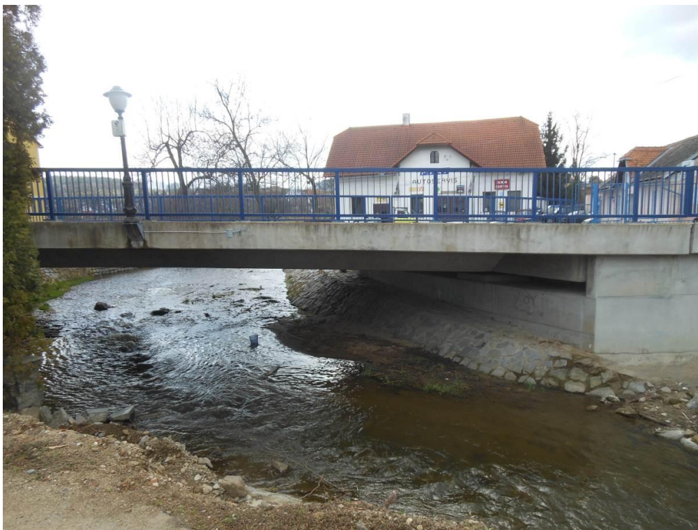
Obr. č. 5: Silniční kamenný most v Kosově Hoře (ř. km 23,886)
