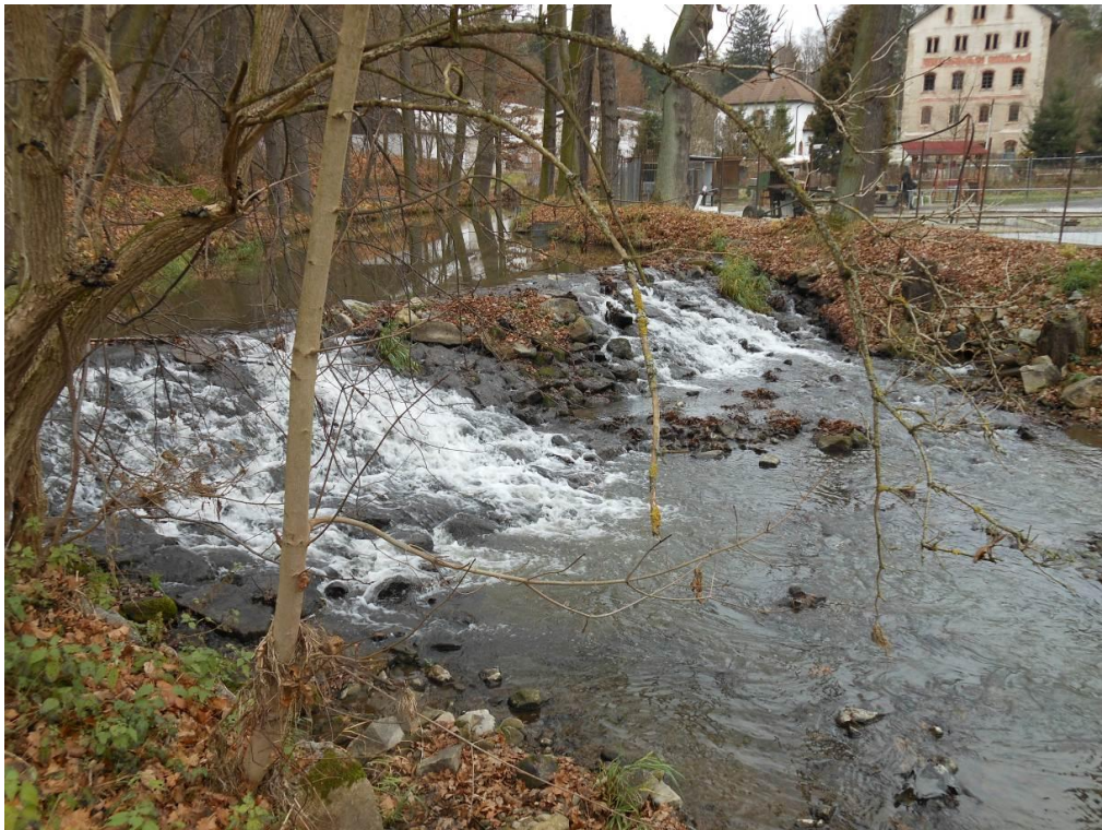
Obr. č. 15: Pevný jez u Červéného hrádku (ř. km 21,293)
