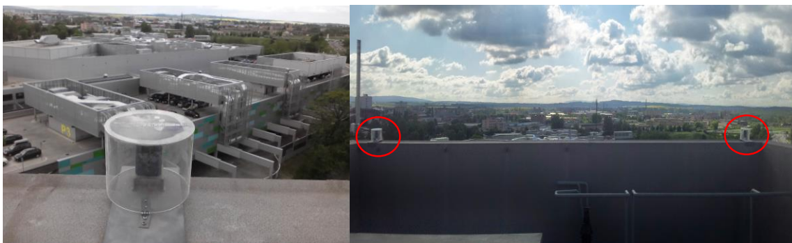
Obr. 10 Pohled z umístění kamery a usazení kamer v rozích budovy
