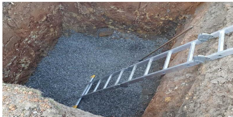
Obr. 12 výkop pro retenční nádrž se základovou deskou. Zdroj [64]
