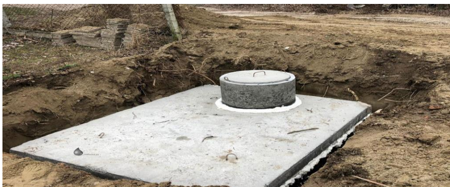
Obr. 6 betonová retenční nádrž PREFA. Zdroj [58]
