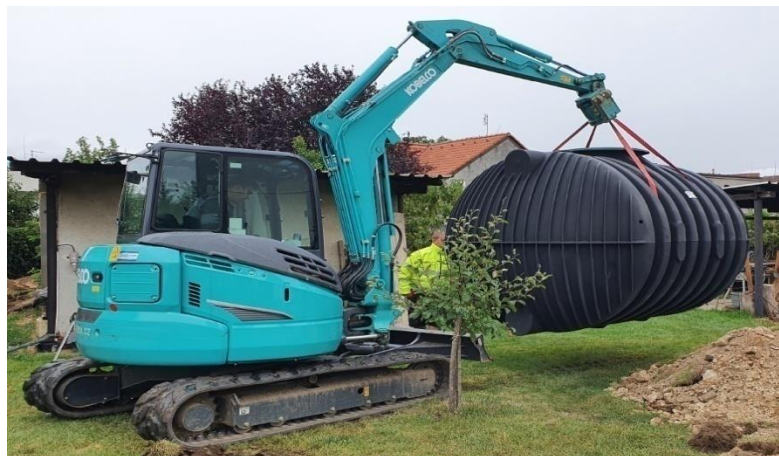
Obr. 15 uložení nádrže pomocí bagru. Zdroj [67]
