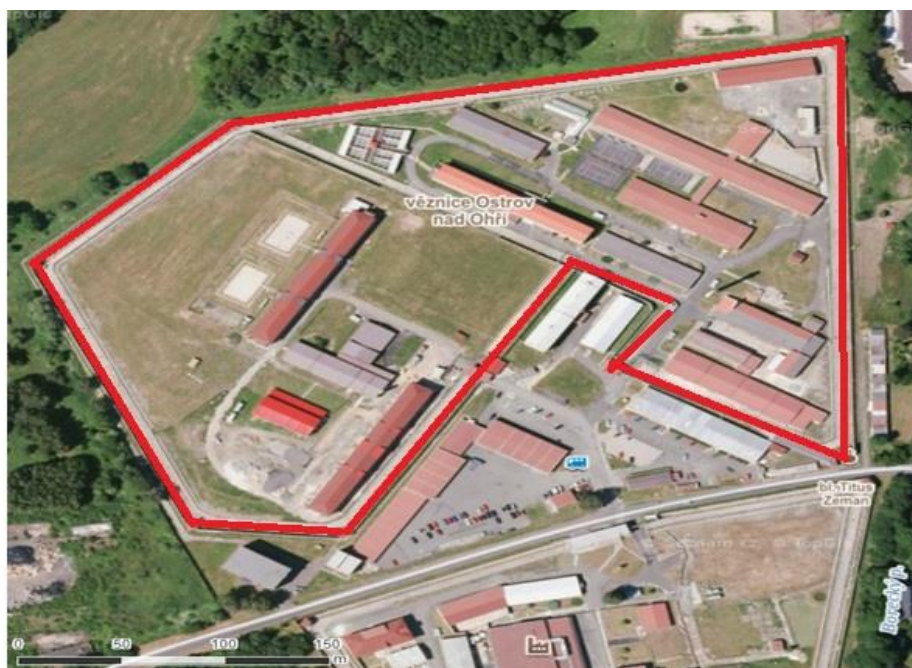
Obr. 17 věznice Vykmánov – objekt A. Zdroj [69]
