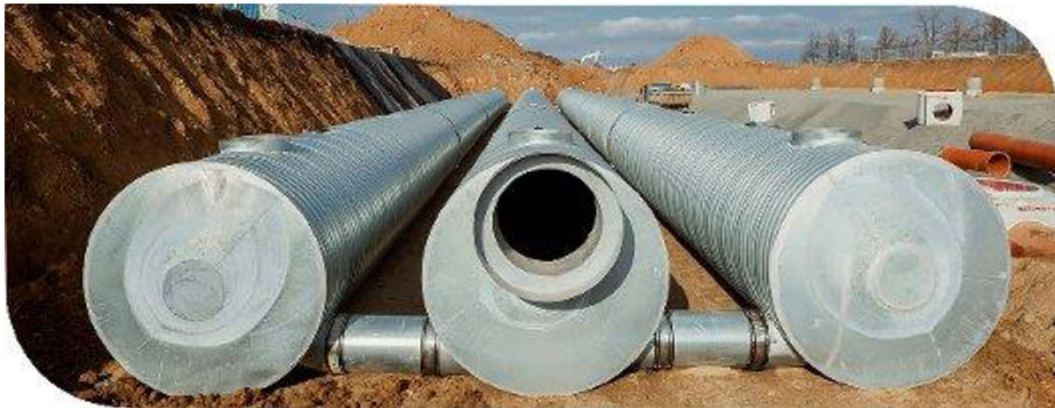
Obr. 8 ocelová retenční nádrž PURECO SPIREL. Zdroj [60]
