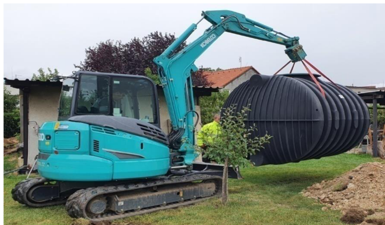
Obr. 15 uložení nádrže pomocí bagru. Zdroj [67]
