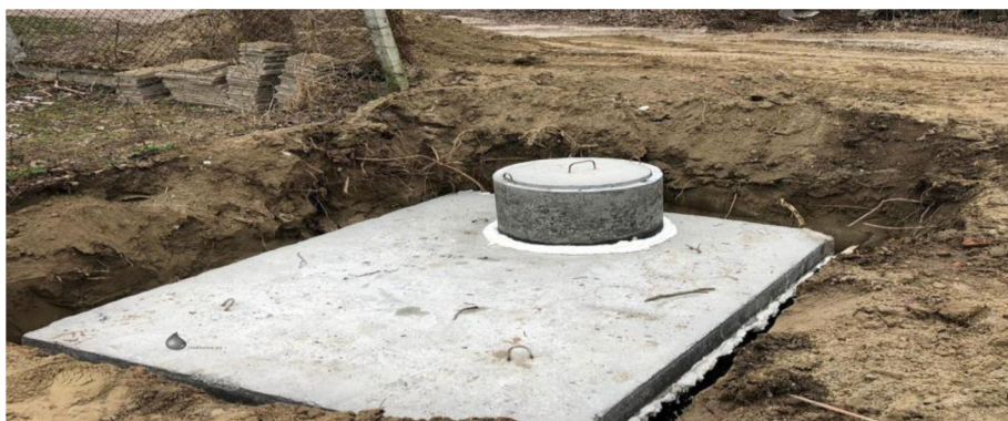
Obr. 6 betonová retenční nádrž PREFA. Zdroj [58]
