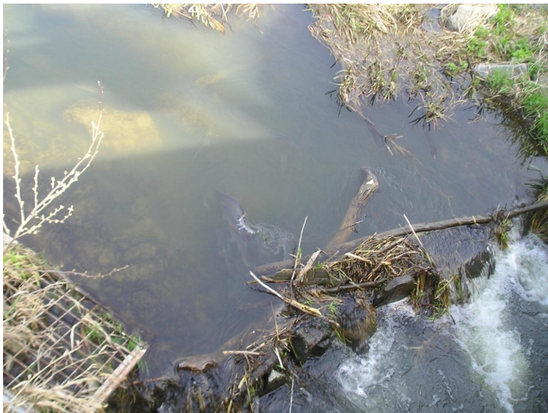
Obr. č. 13 – Zanesena výstupní překážka znemožňující migraci v RP, autor Ondřej Kubalík
