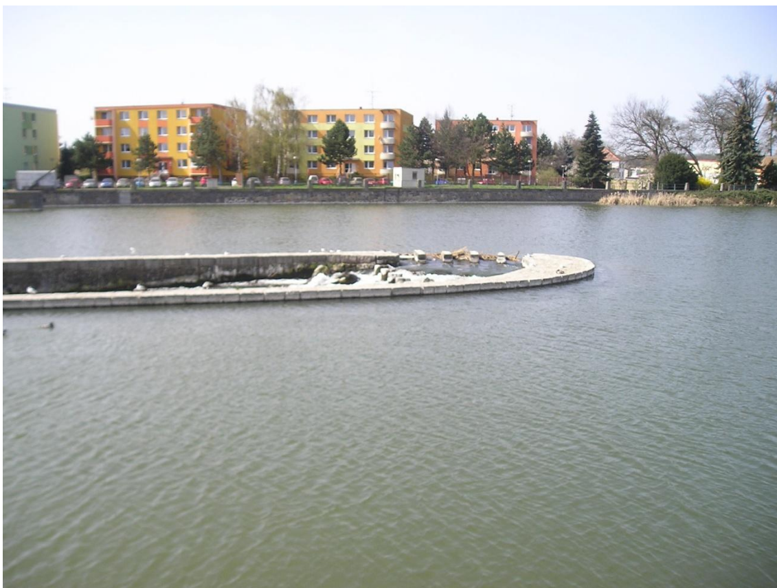
Obr. č. 16 – Částečně ucpaný výstup z RP, autor Ondřej Kubalík
