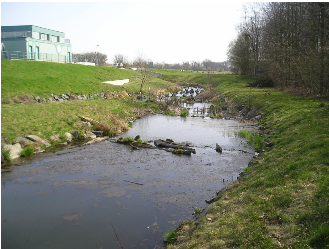
Obr. č. 10 – Zanesená část RP nečistotami, autor Ondřej Kubalík
