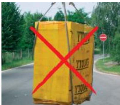
Obrázek 12 - Ukázka, jak nemanipulovat s paletami. [6]
