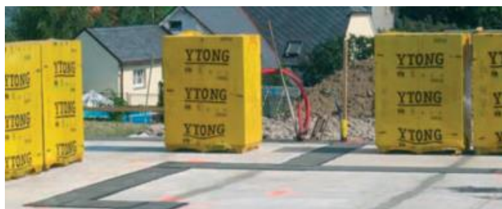
Obrázek 7 - Skladování palet se zdivem Ytong. [6]
