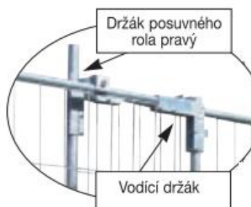
Obrázek 5 - Držák posuvné brány. [4]
