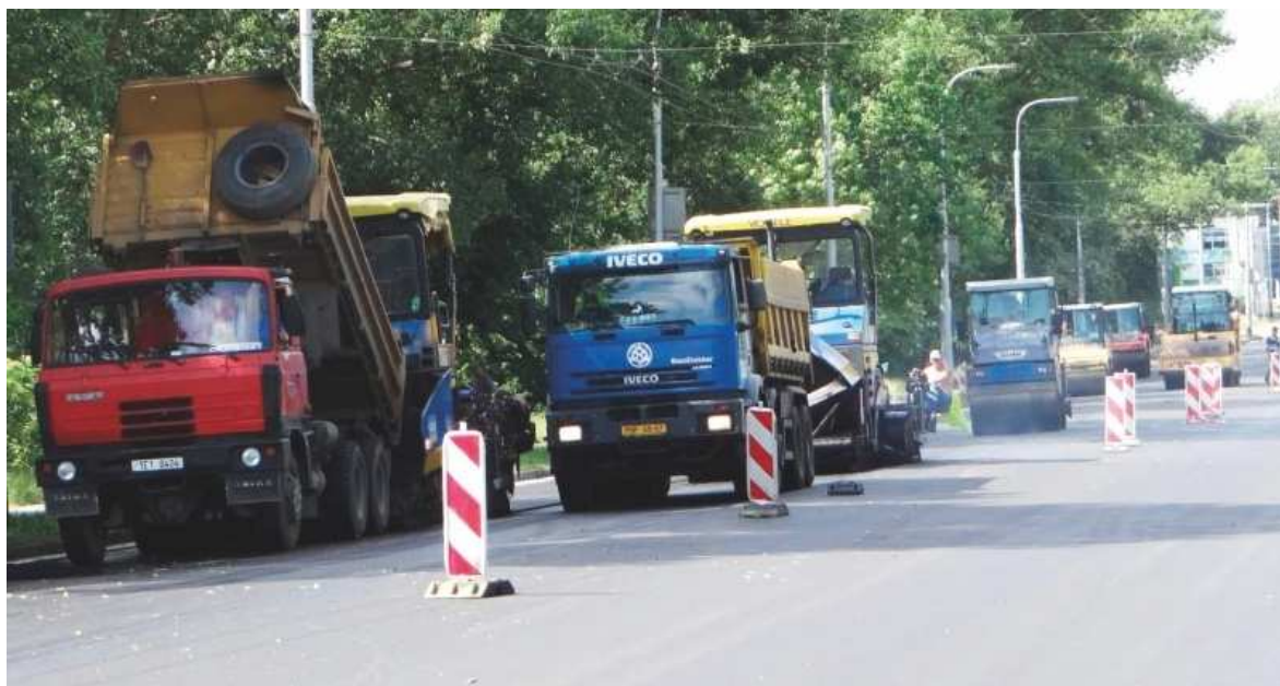
Obrázek 3.1 – Pokládka obrusné vrstvy BBTM 5A, CRmBs použitím 2 finišerů a 4 válců
