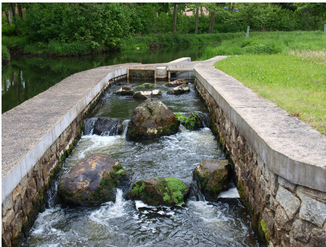
Obrázek č. 17: Vtok do rybního přechodu Kynšperk a prvky bránící migraci ryb mimo monitorovací zařízení RiverWatcher Vaki (Foto: autor).
