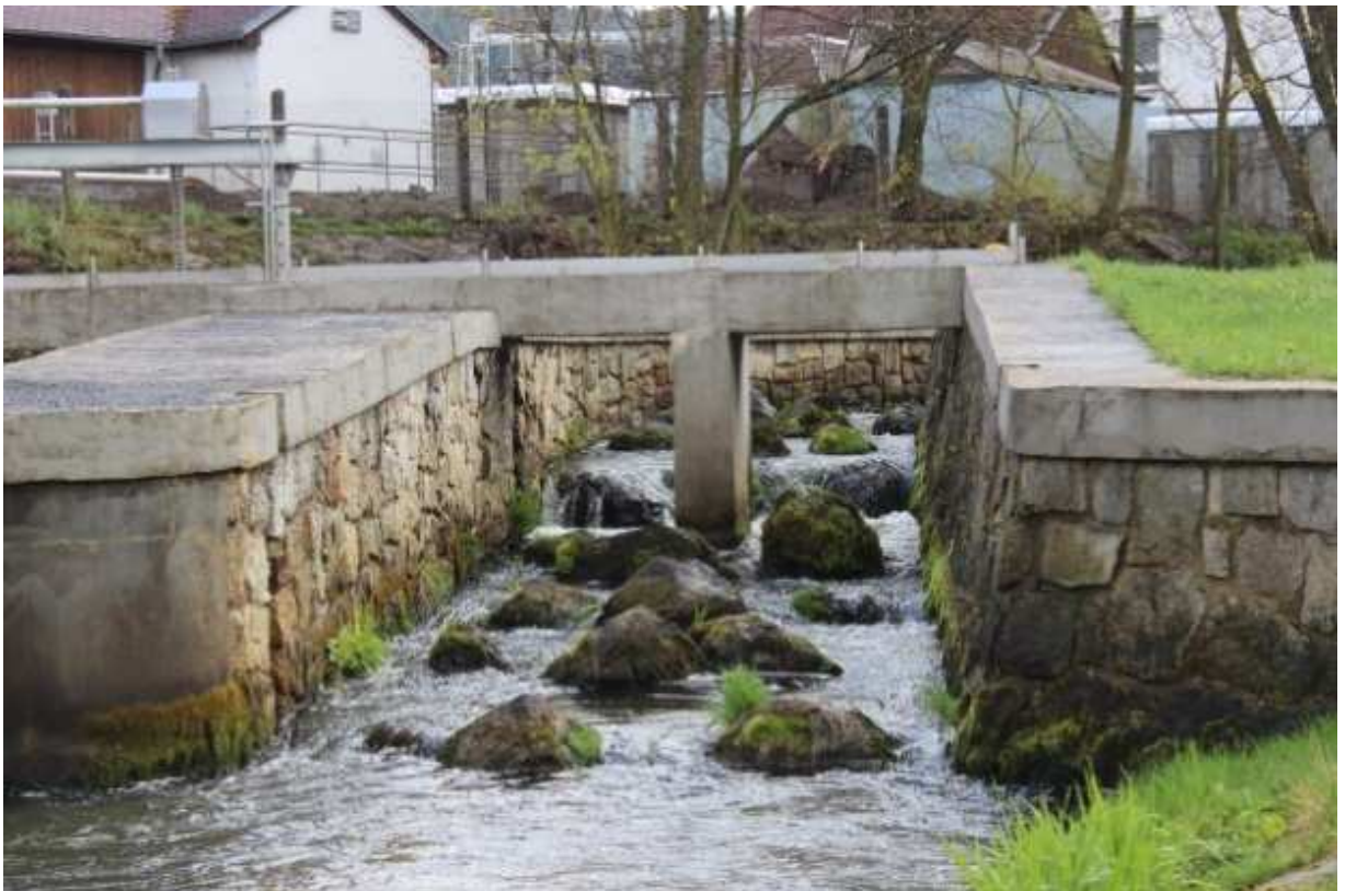
Obrázek č. 16: Pohled na výústní trať rybího přechodu Kynšperk (Foto: autor).
