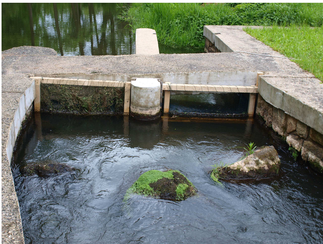
Obrázek č. 18: Detail prvků bránících migraci ryb mimo monitorovací zařízení (Foto: autor).
