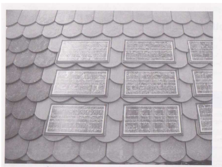
Obrázek – 2 – 3 – Fotovoltaický panel integrovaný do střešní krytiny [8]
