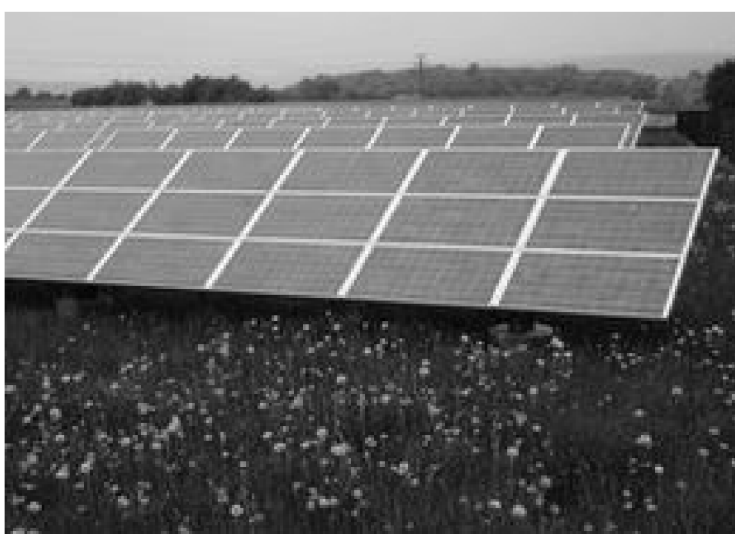
Obrázek – 2 – 4 – Fotovoltaický panel na terénu [9]
