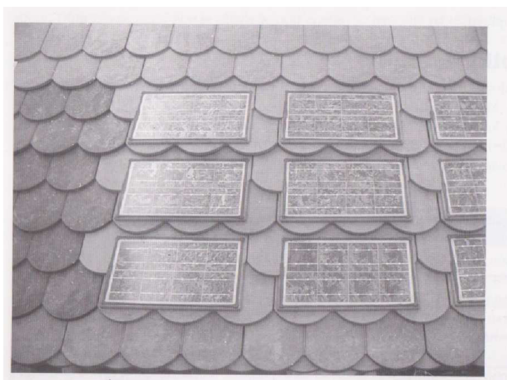
Obrázek – 2 – 3 – Fotovoltaický panel integrovaný do sřešní krytiny [8]
