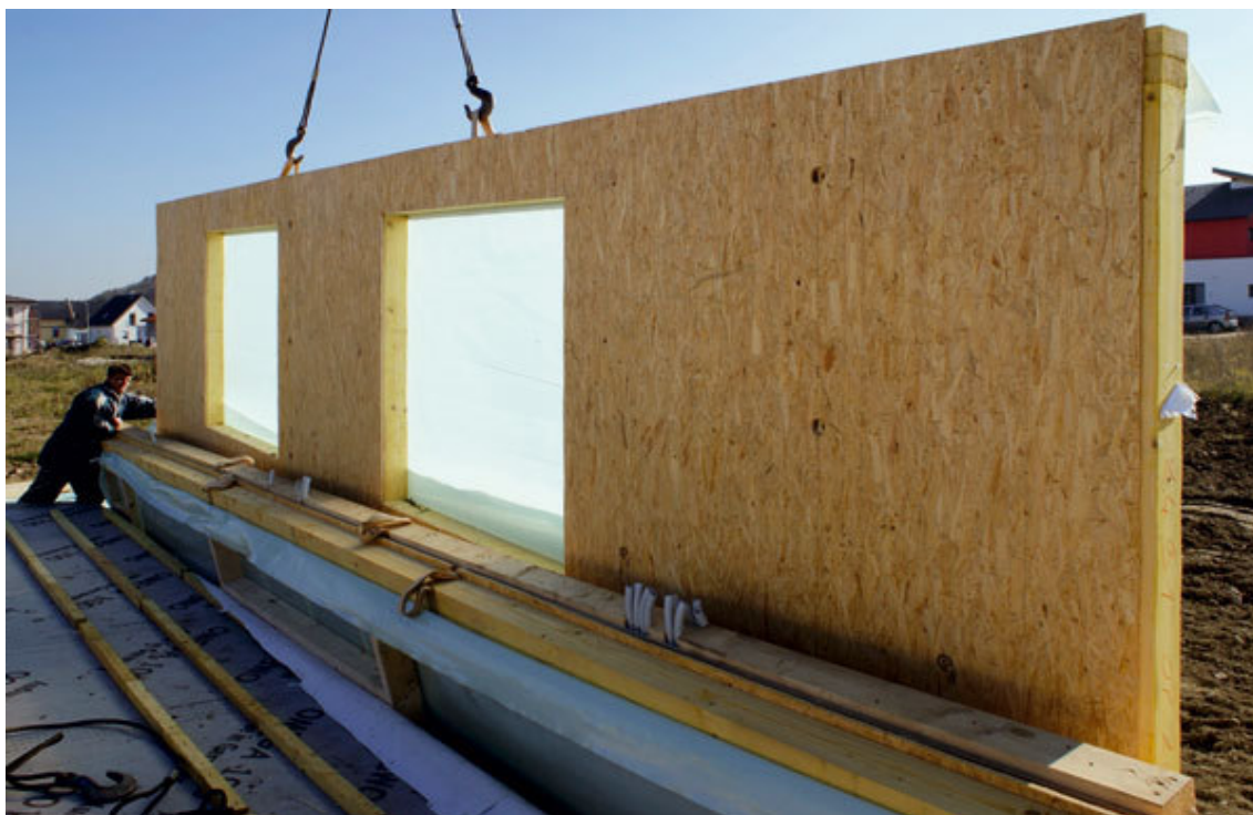
Obrázek 11 – Příklad panelové montáže, převzato od Šišoláka (2013) | © Drevstav
