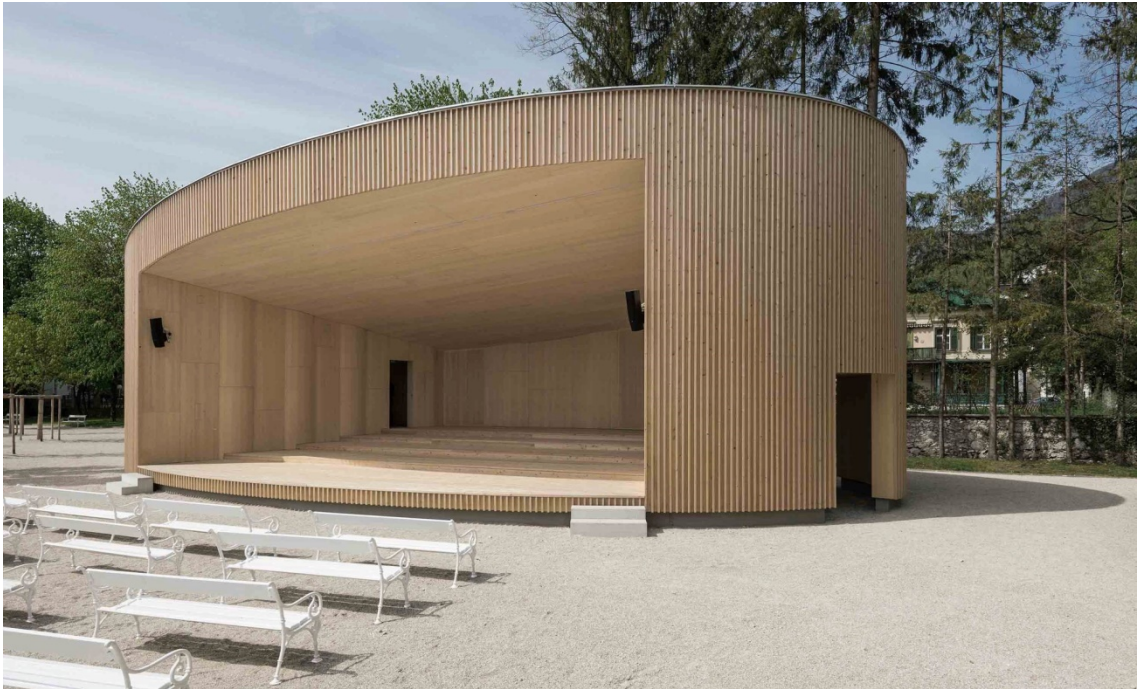
Obrázek 16 – Hudební pavilon Bad Ischl z archivu Two in a Box Architekten (2014) | © Simon Bauer
