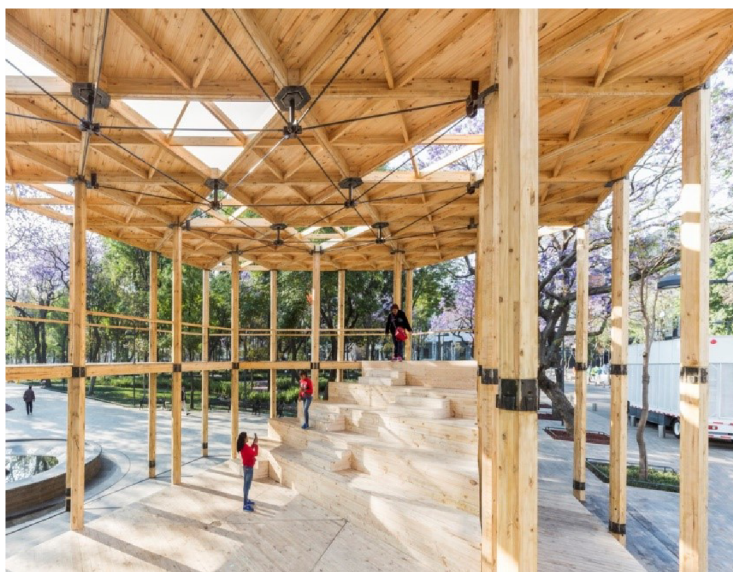
Obrázek 17 – House of Switzerland Pavilion, převzato z ArchDaily (2017) | © Sandra Pereznieto
