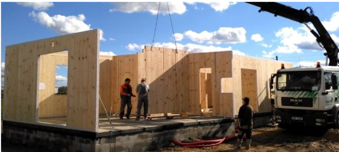
Obrázek 24 – Pokládání CLT panelů jeřábem, převzato od Nešporové (2017) | © dekwood.cz
