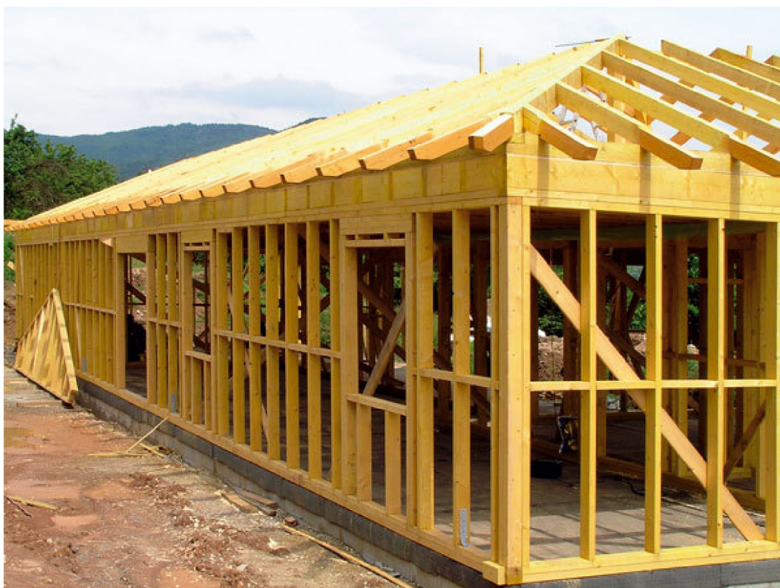
Obrázek 10 – Příklad lehkého dřevěného skeletu, převzato od Šišoláka (2013) | © Drevstav
