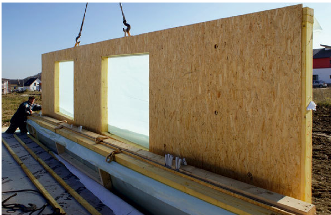
Obrázek 11 – Příklad panelové montáže, převzato od Šišoláka (2013) | © Drevstav
