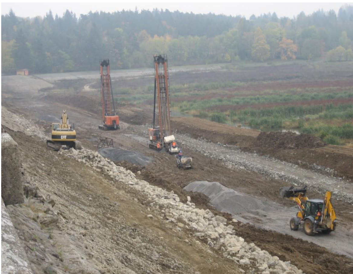
Obr. 3.3 Provádění úprav dna nádrže [12]
