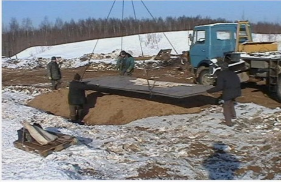
Příloha 3 Vyložení balíčku na výbušném místě a instalace pískového polštáře
