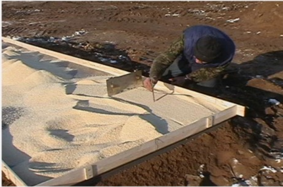
Příloha 4 Naklazení výbušniny a kontrola tloušťky rovnoměrnosti vrstvy
