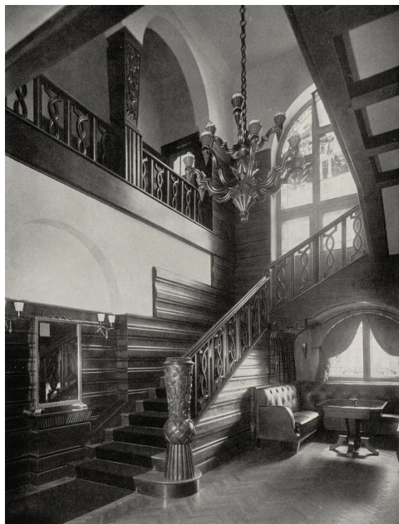
82. Otto Prutscher, vila bratří Bellakových, 1927, nová dvoupodlažní hala.
