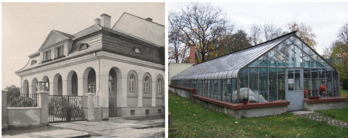
70. Otto Prutscher, Flemmichova vila, 1914–1917, zleva správní budova a skleník.
