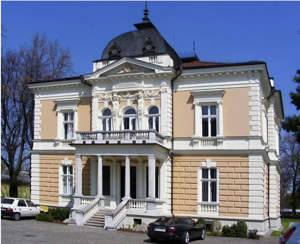
21. Josef Hartel, vila Gustava Kandlera, 1892, průčelní fasáda.
