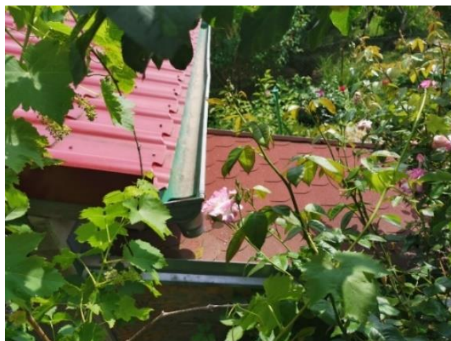
Obr. 4.35 Plechová a živičná krytina na sousedních objektech (červená barva)
