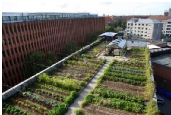
Obr. 2.3 - Střešní zahrada o ploše 600 m 2 s 90 tunami půdy (Kodaň, Dánsko) na pětipodlažní budově nad aukcí starých automobilů 3
