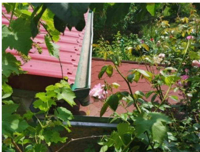
Obr. 4.35 Plechová a živičná krytina na sousedních objektech (červená barva)
