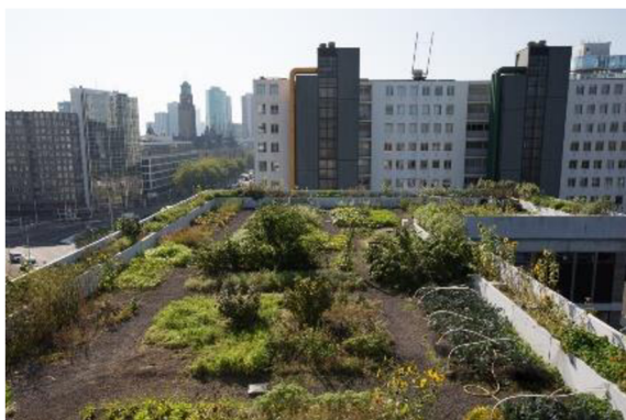
Obr. 2.2 - Střešní farma na střeše kancelářské budovy o rozloze 1000 m 2 v nizozemském Rotterdamu. Pěstuje se zde zelenina, ovoce, květiny a chovají včely. 2
