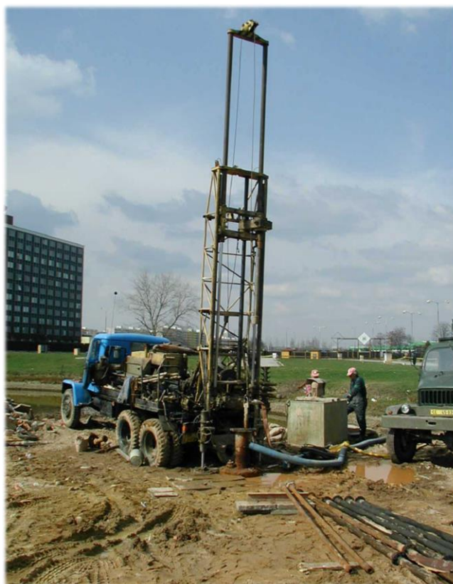
Obr. 6.3 Vrtná souprava UBG [16]
