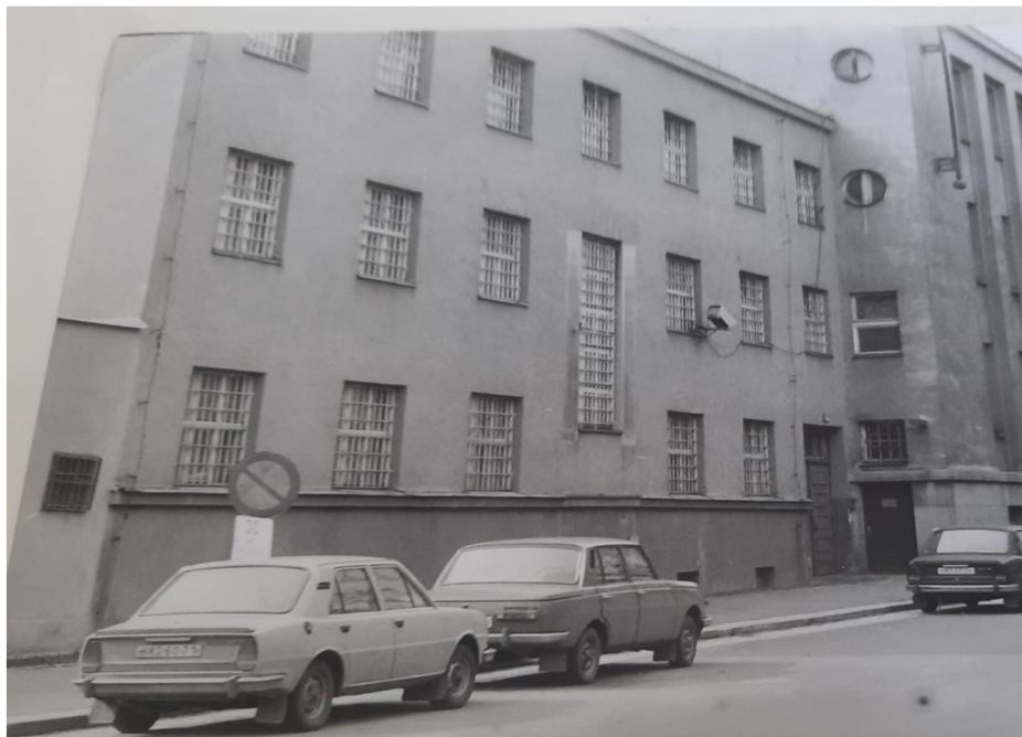
Obrázek 29.: Boční vchod do vazební věznice v Hradci Králové - fotoarchiv Kabinetu dokumentace a historie VSČR
