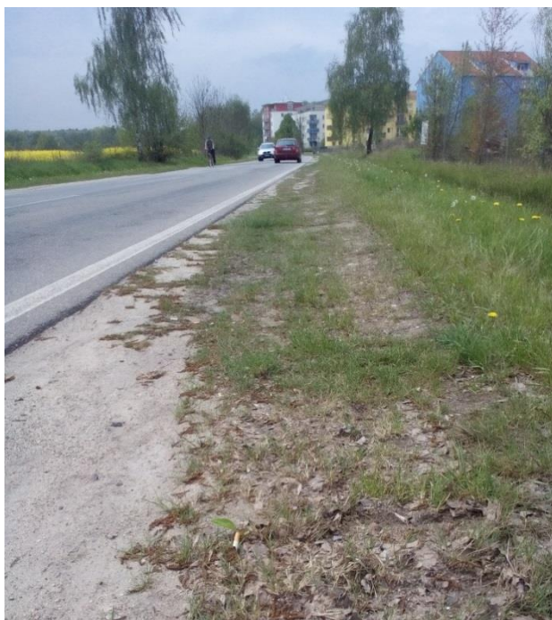
Obr. č. 4 Lokalita č. 2 Branišovská (Archiv autorky)
