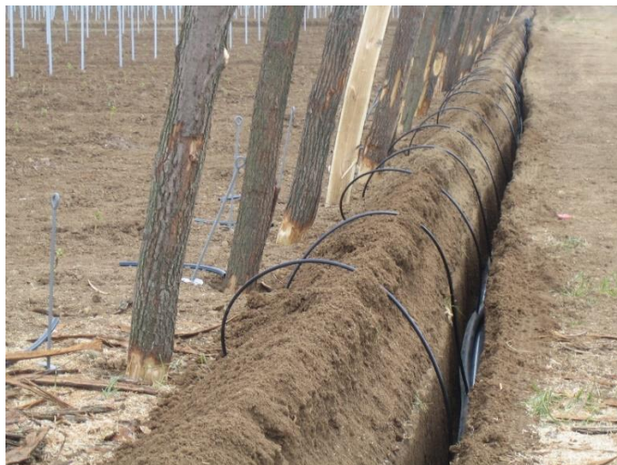
Obrázek 5 PE hadice použita jako vývod ke kapkové závlaze ve vinici (zdroj: Vlastní archiv)
