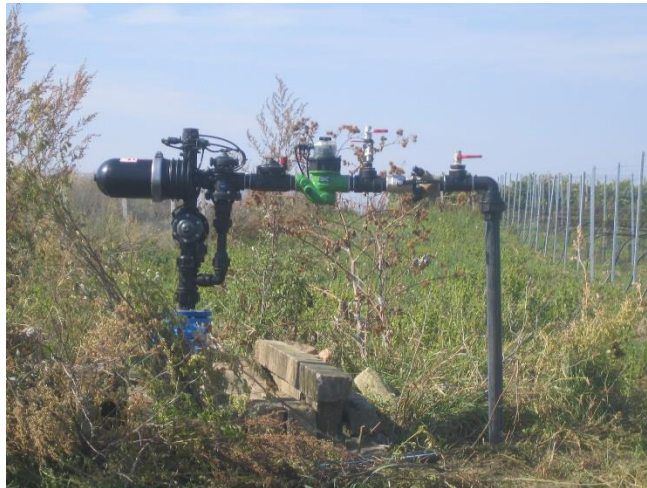
Obrázek 3 Lamelový filtr napojený na závlahový řád (zdroj: Vlastní archiv)
