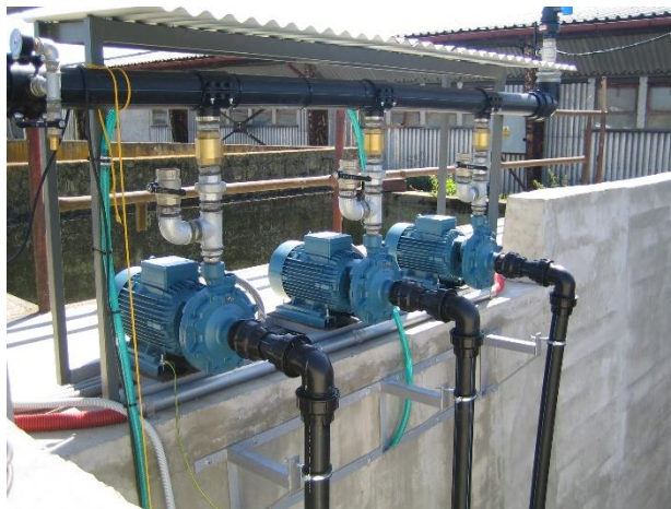
Obrázek 2 Jedna z možností uložení čerpadel (zdroj: Vlastní archiv)
