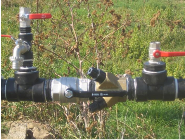
Obrázek 7 Soustava kulových ventilů (zdroj: Vlastní archiv)
