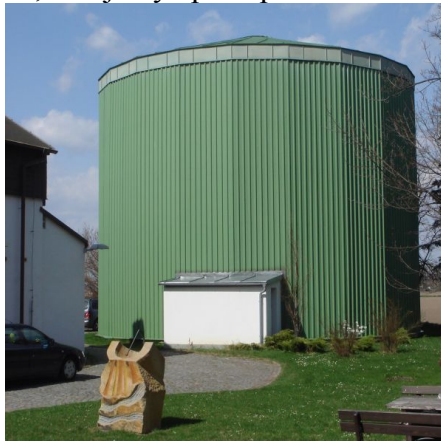
Obr. 4 Vodní zásobník pro dlouhodobou akumulaci ve Slatiňanech [22]
