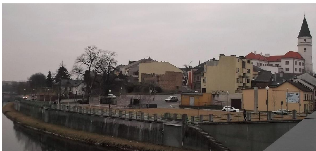
75. Přerov, pohled na severozápadní stranu zámku, fragment barbakánu a lokalitu Na Marku.
