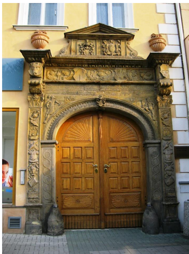
41. Prostějov, měšťanský dům „Onšův“ č. p. 202, náměstí T. G. Masaryka, kolem 1540, portál.
