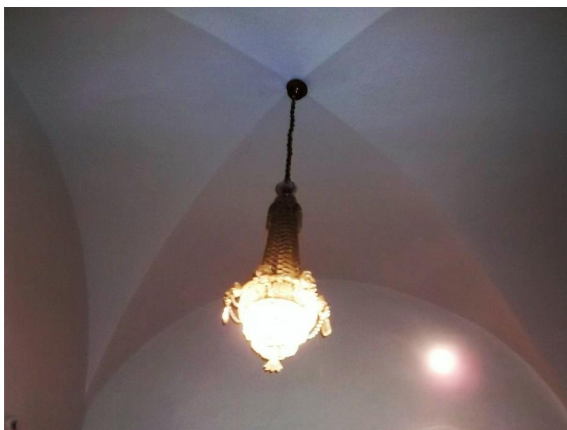
63. Přerov, zámek, Horní náměstí č. p. 1, druhá polovina 16. století, místnost s renesanční valenou klenbou se styčnými a protilehlými lunetami v prvním patře.
