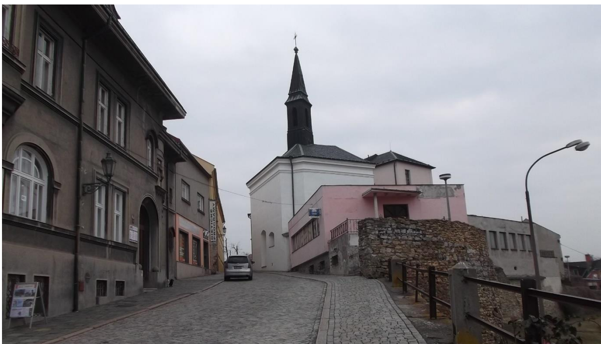
53. Přerov, městské hradby, Žerotínovo náměstí, 90. léta 15. století, fragmenty bývalého barbakánu.
