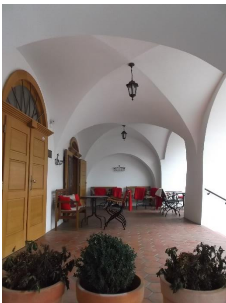
14. Přerov, měšťanský dům č. p. 11, Horní náměstí, jádro z konce 15. století, přestavěno v druhé polovině 16. věku, dvě pole loubí s křížovými klenbami.
