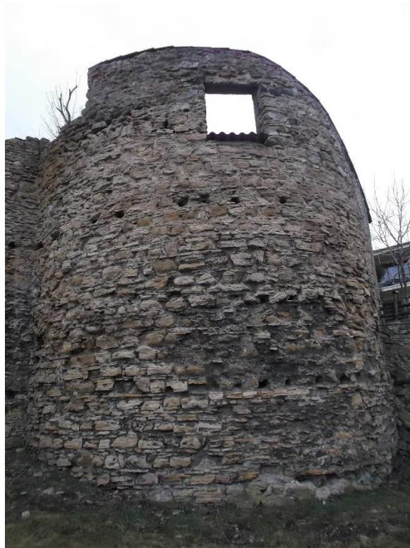
50. Přerov, městské hradby, ulice Spálenec, 90. léta 15. století, detail okrouhlé bašty se střílnami.
