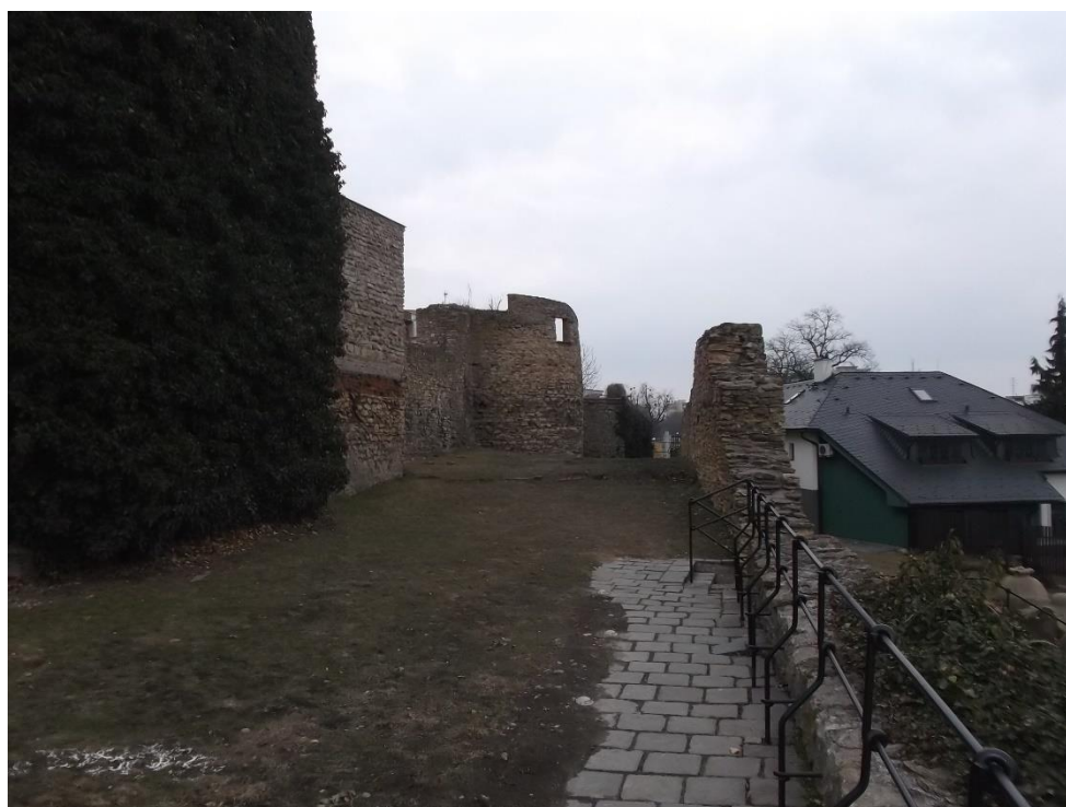
49. Přerov, městské hradby, ulice Spálenec, 90. léta 15. století, fragmenty trojitého systému hradeb.
