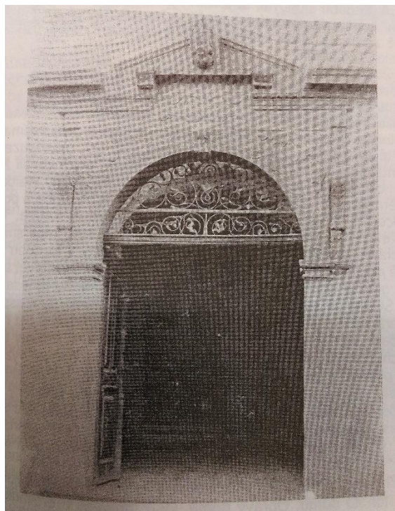
36. Přerov, měšťanský dům, zv. Korvínský, Horní náměstí č. p. 31, stav z přelomu 19. a 20. století, portál domu.
