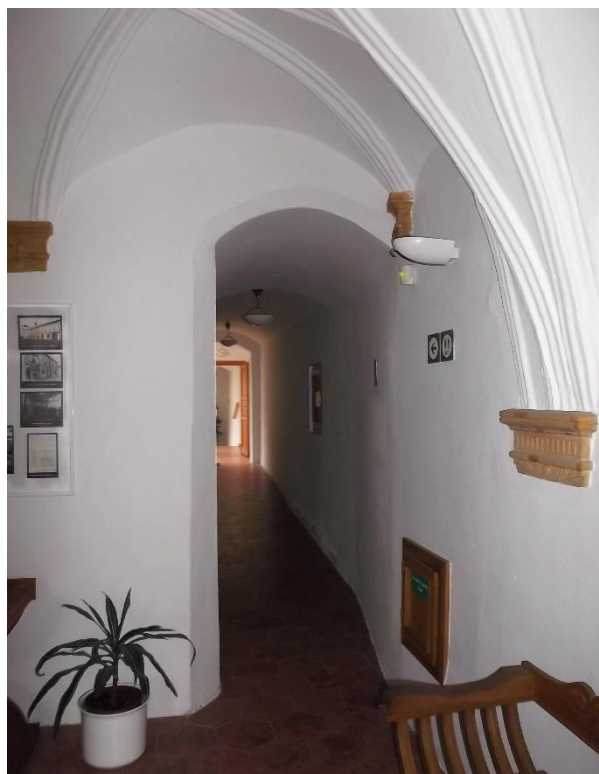
31. Přerov, měšťanský dům, zv. Korvínský, Horní náměstí č. p. 31, 1530–1535, pohled na chodbu s valenou klenbou.
