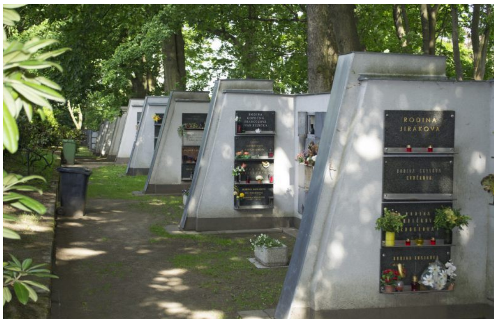
12 Rudolf Bitzan, Krematorium a urnový háj v Liberci, 1915-1917, nedatováno, kolumbární zeď – současný stav. Autor snímku neuveden (zdroj: http://krematoriumliberec.cz/fotogalerie/hrbitov-a-kolumbaria/kolumbarium-kolumbarni-zed vyhledáno 9.4.2016)
