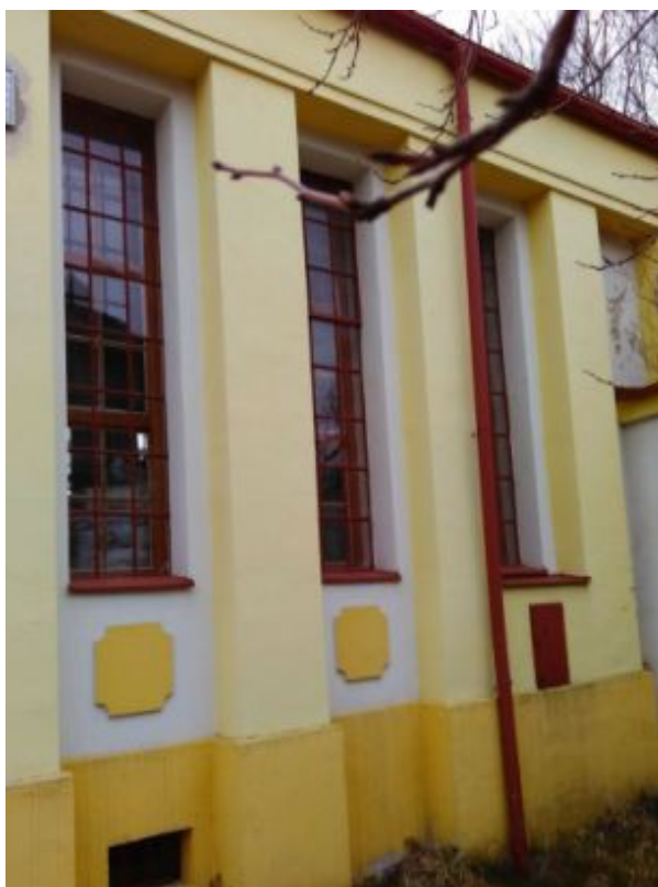
9 Rudolf Bitzan, Městský vodojem ve Frýdlantě, 1913, 2016, boční stěna s vertikálními okny. Snímek autorky.
