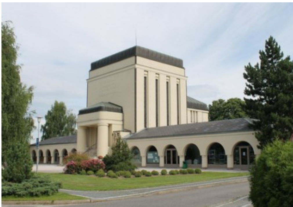
10 Rudolf Bitzan, Krematorium a urnový háj v Liberci, 1915-1917, 2011, pohled na stavbu z ulice. Snímek Filip Landa (zdroj: http://liberec-reichenberg.net/stavby/karta/nazev/10-krematorium-a-urnovy-haj vyhledáno: 9.4.2016)
