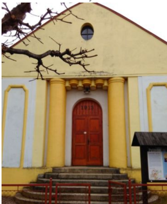
8 Rudolf Bitzan, Městský vodojem ve Frýdlantě, 1913, 2016, hlavní vchod. Snímek autorky.
