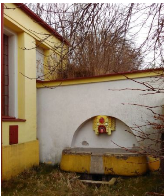
7 Rudolf Bitzan, Městský vodojem ve Frýdlantě, 1913, 2016, kašna. Snímek autorky.
