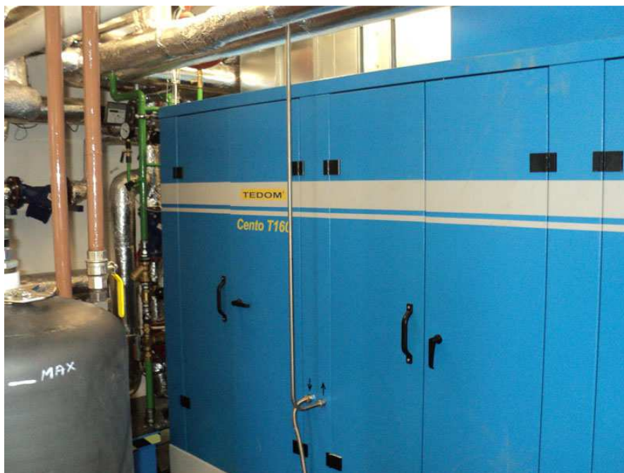
Obr.: Kogenerační jednotka na řepkový olej v obchodním domě Tesco v Jaroměř, foceno při exkurzi, jaro 2014
