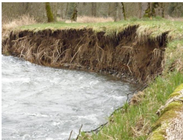
Obr. č. 4: Břehová eroze (conservationdistrict.com)
