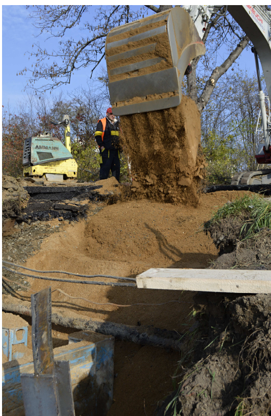
Obr. 14 Zасыпání kopané sondy
