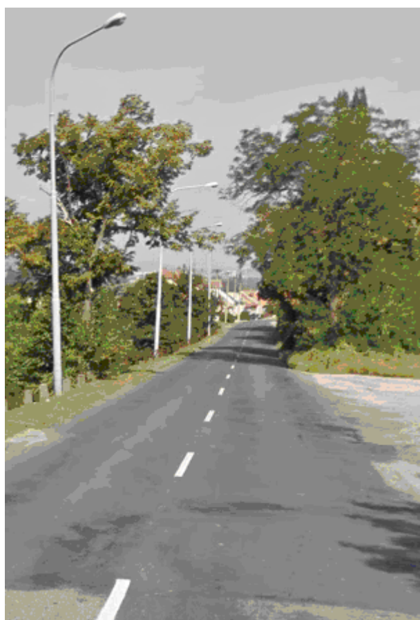
Obr. 10 Komunikace před opravou
