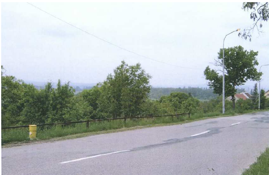
Obr. 8 Fotografie poruch komunikace
