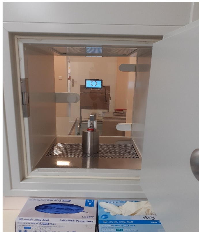
Obrázek 3 Materiálová propust RF mezi přípravnou a aplikační místností
