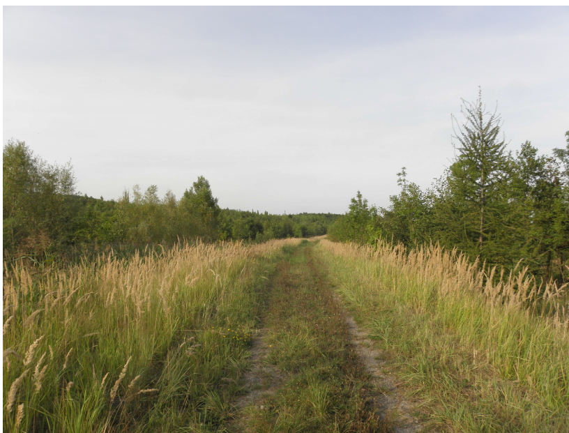
obr. č. 30 Vybudované cesty rozdělující I. a III. etapu (autor 2011)
