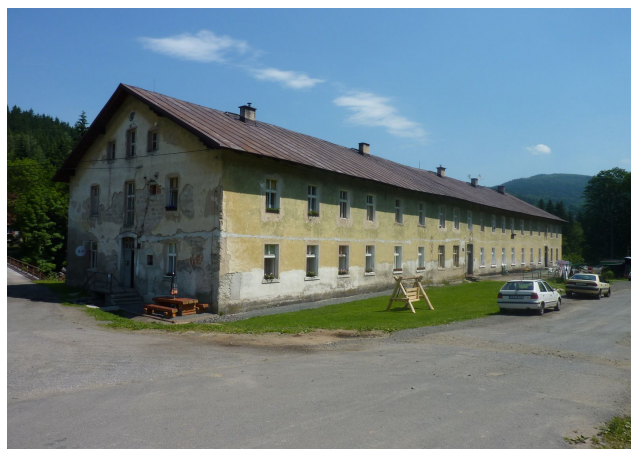
Obrázek 26: Objekt Kořenov č.p. 728 (2012), foto Hübner
