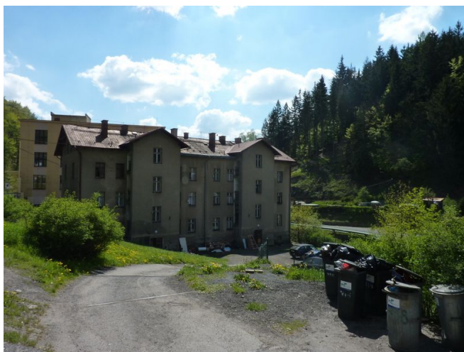
Obrázek 11: Objekt č.p. 315 v lokalitě Tanvald Krkonošská (2012, 2016), foto Hübner
