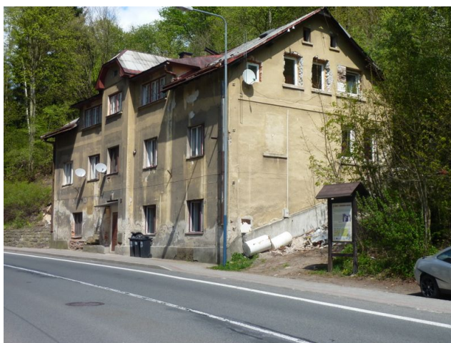
Obrázek 10: Objekt č.p. 339 v lokalitě Tanvald Krkonošská (2012, 2016), foto Hübner
