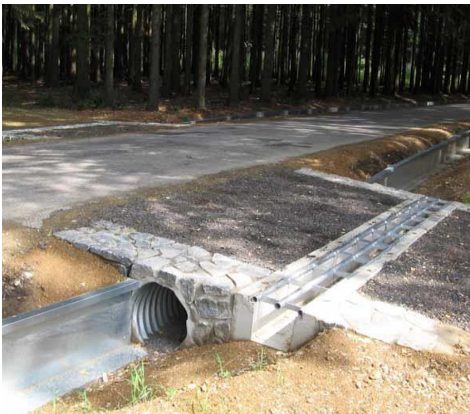
Obr. č. 9: Bariéra a podchod pro obojživelníky, obec Řetová zdroj: http://zpravodaj.probit.cz/ , AUTOR: Miloslav Renčín
