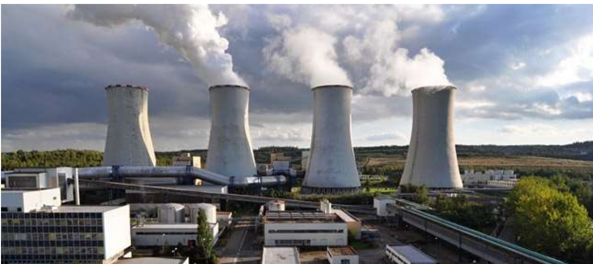
Obrázek 10: Chladicí věže elektrárny ve Chvaleticích [39]
