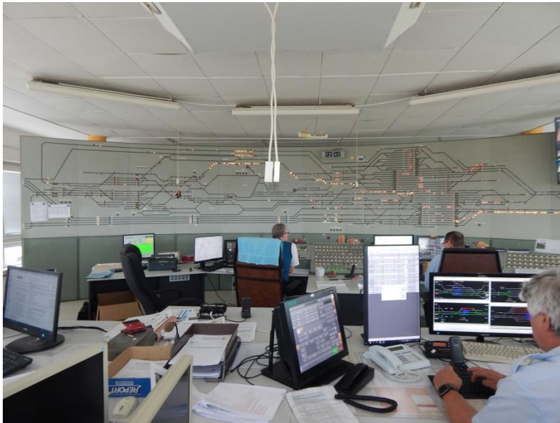
Obrázek 10: Panel reléového zabezpečovacího zařízení s číslicovou volbou
