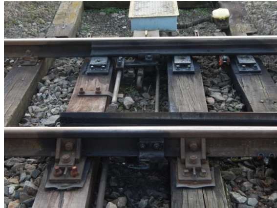
Obrázek 1: Hákový závěr, v popředí háková stěžejka s vyklesnutým hákem
