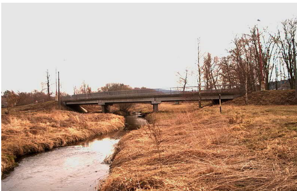
obr. č. 3 Silniční most nacházející se n ř.km 7,029
