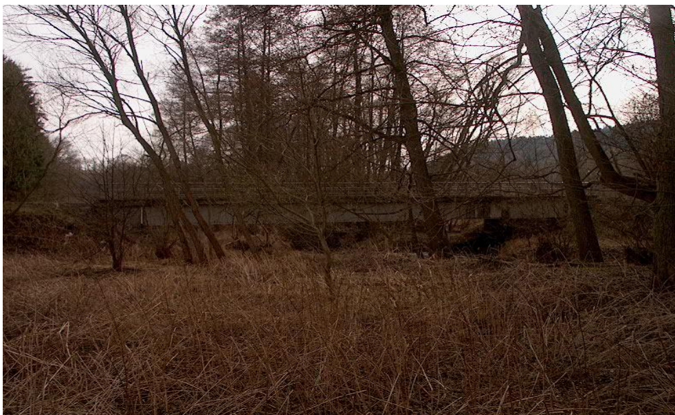
obr. č.2 Silniční most nacházející se n ř.km 8,308
