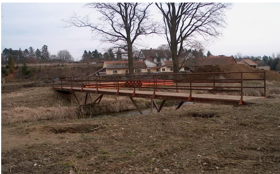
obr. č. 4 Železobetonová lávka nacházející se n ř.km 6,904
