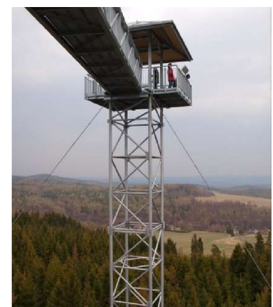
Obr. č. 4 – Věž B [1]
