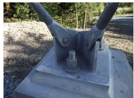
Obr. č. 7 – Kotvení táhel [1]
