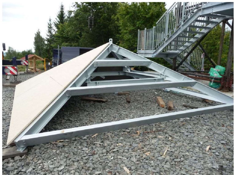
Obr. č. 6 – Montáž střechy věže B [1]
