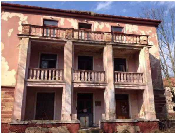
Obrázek 43 Část budovy "Štábů" z 50. let 20 století, (Archiv Města Milovice, 2023).
