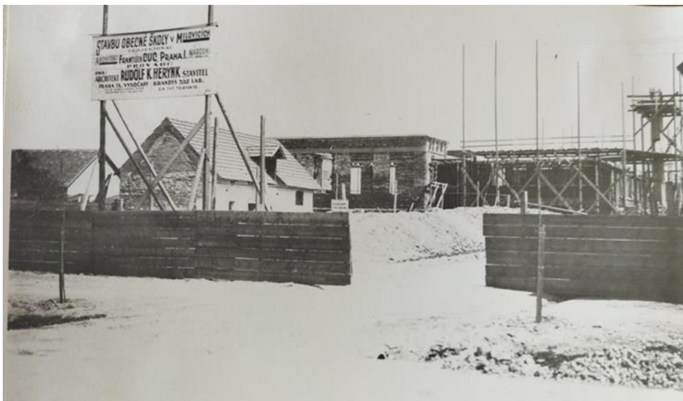
Obrázek 131 Stavba nové školy v ulici Pionýrů, 1930 (Archiv SOKA Nymburk, 2023).
