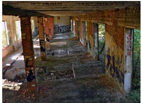
Obrázek 76 Interiér tankové střelnice (Archiv Tomek., 2023).
