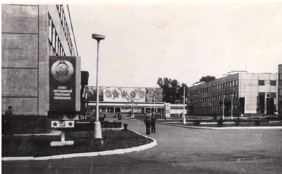
Obrázek 24 Vnitroblok kasáren v pozadí s kinosálem v ulici Topolová – Mladá v roce 1979 (Archiv Soka Nymburk, 2023).
