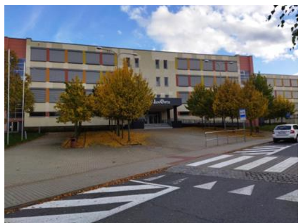
Obrázek 46 Rekonstruovaná základní škola JUVENTA.
