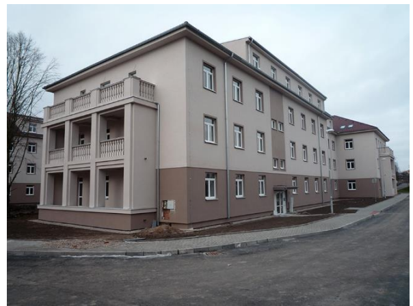
Obrázek 44 Zrekonstruované budovy "Štábů".
