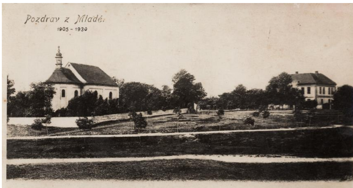
Obrázek 105 Pohled na obec Mladá – kostel a faru, 1905-1930 (Archiv SOka Nymburk, 2023).
