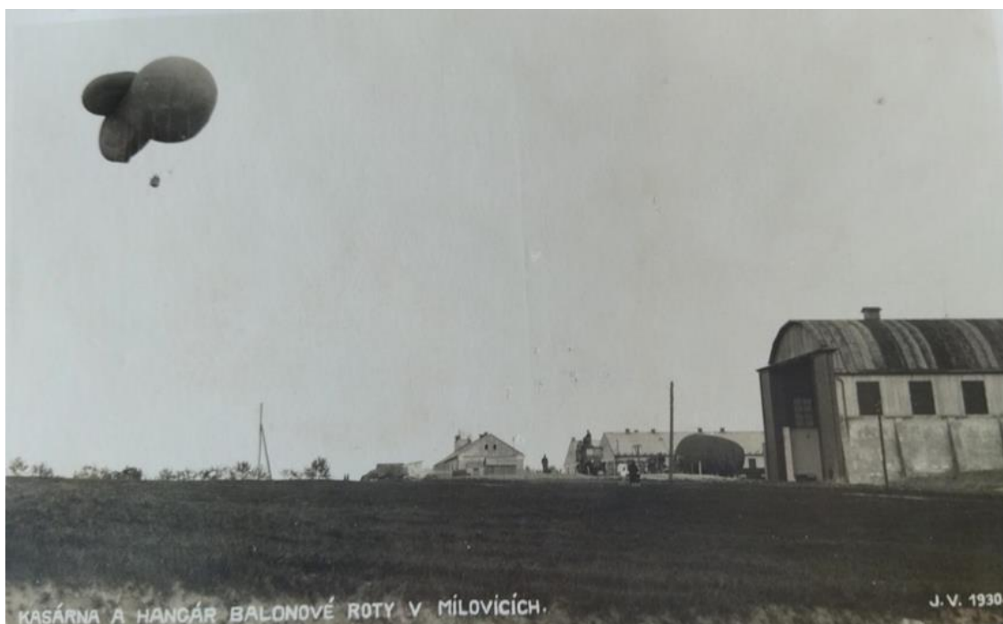
Obrázek 22 Kasárna a hangár balonové roty v Milovicích z roku 1930 (Archiv SokA Nymburk, 2023).
