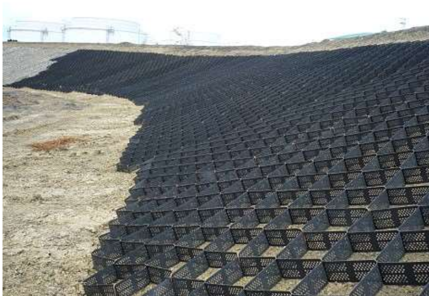
Obrázek 3: Aplikace geobuněk před zásypem na svahu (Geomat, 2011).
