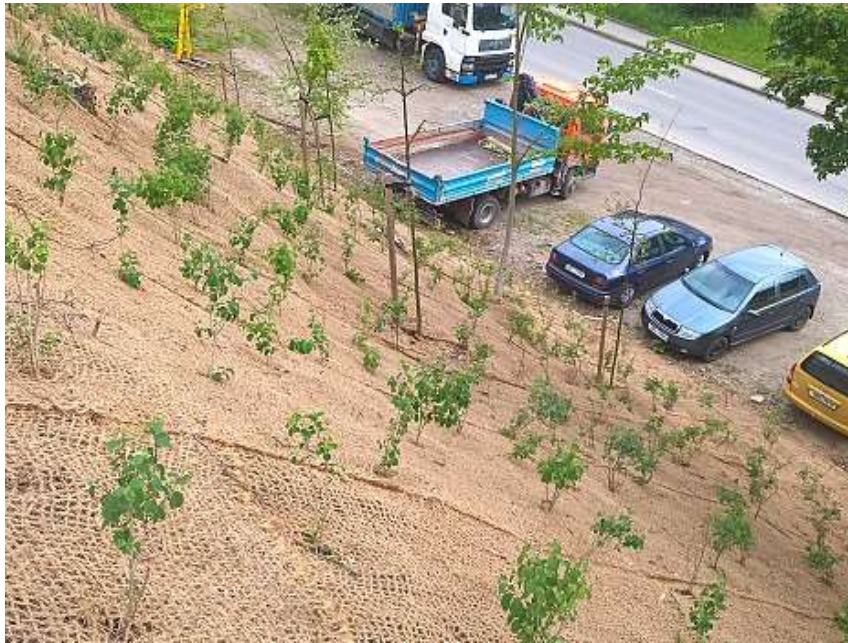
Obrázek 1: Svah plošně chráněný geosyntetikou s výsadbou dřevin (Geomat, 2017)
