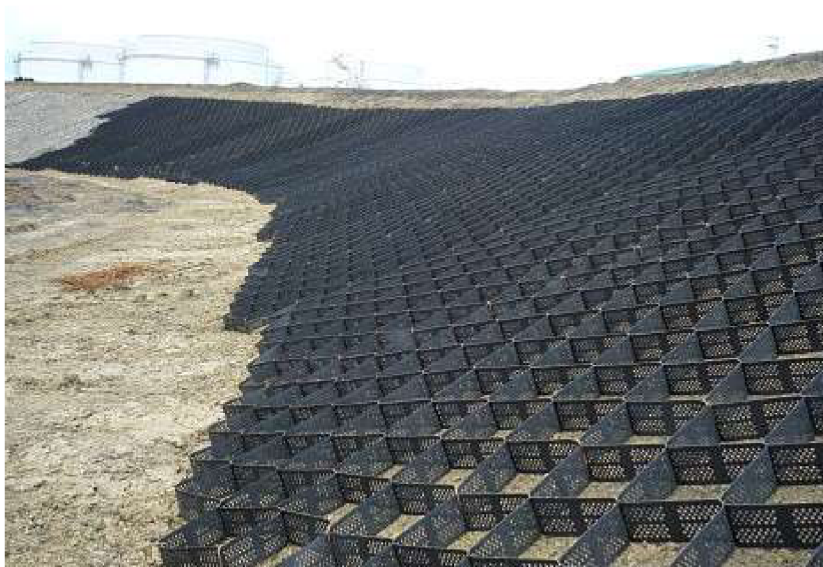
Obrázek 3: Aplikace geobuněk před zásypem na svahu (Geomat, 2011).
