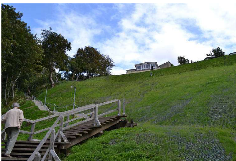
Obrázek 4: Svah chráněný proti erozi zatravněnými syntetickými dílci (ECORASTER, 2023).
