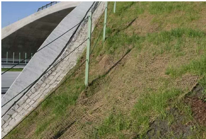
Obrázek 2: Svah osetý za pomoci kokosových protierozních sítí (Juta, 2021)
