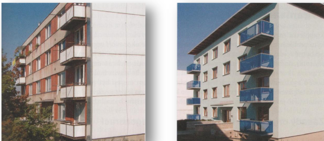
Obr. č. 6 - Panelový dom Oblá 3 pred a po regenerácii [7]
